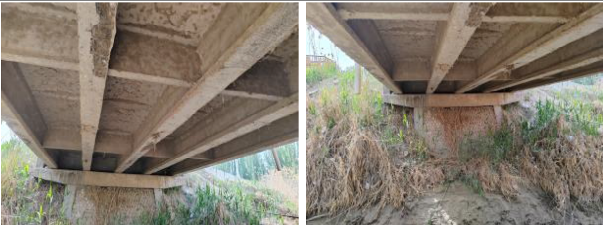
桥梁结构照片
