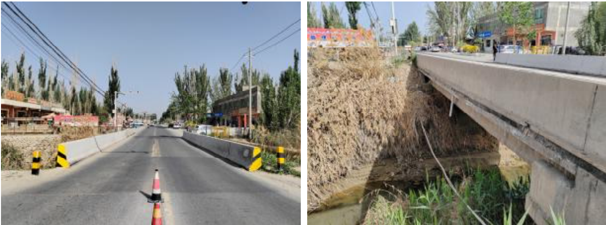
桥梁现状照片（正面、侧面）
