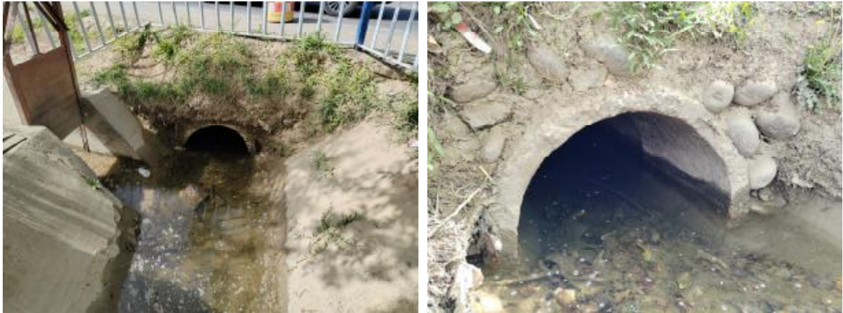
涵洞现状照片（右洞口、左洞口）
