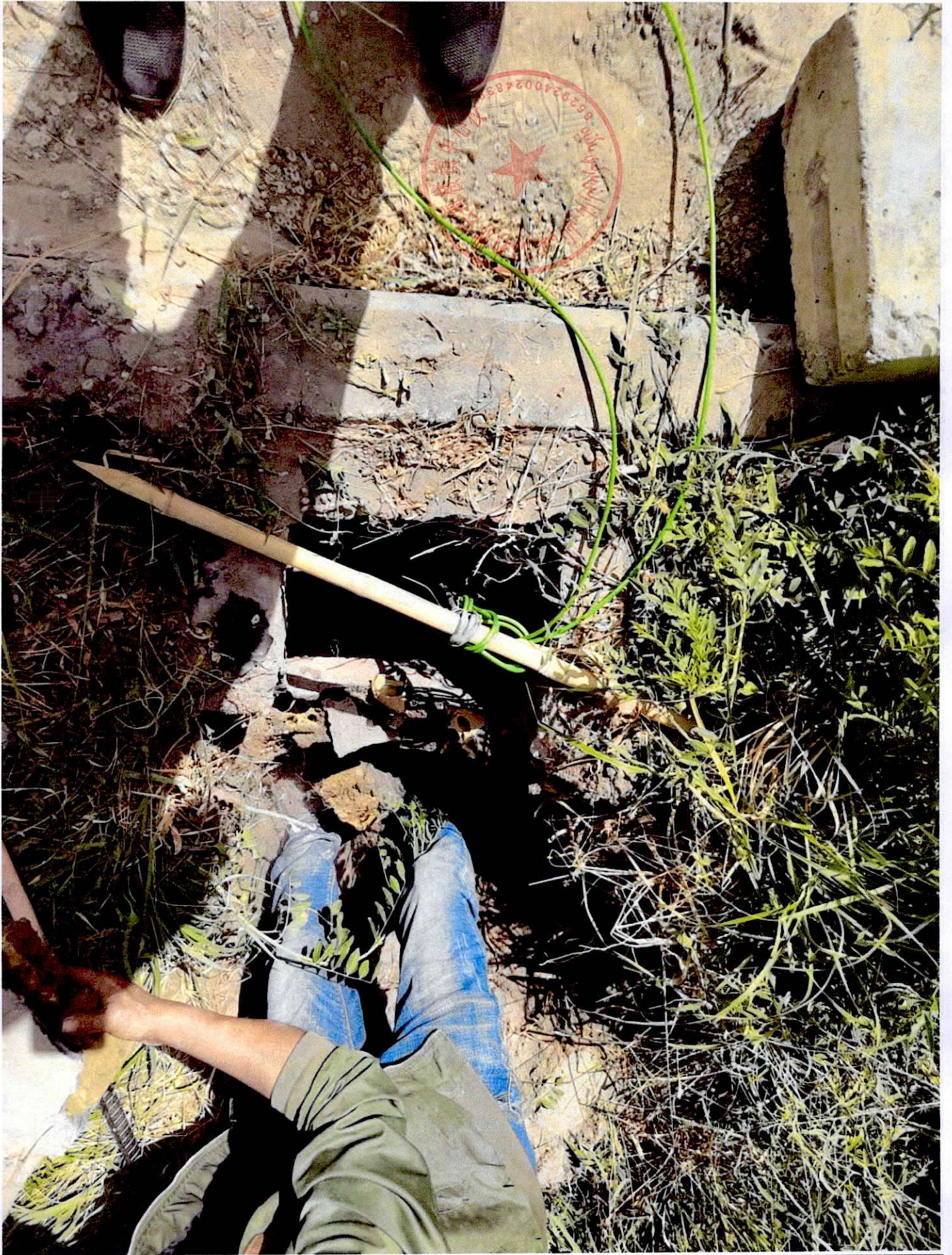
沙雅县海楼镇中心校维修自来水管
