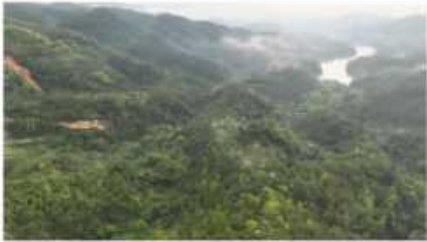
山间道路破坏，无人机高空查路
