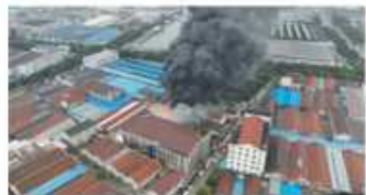
火灾现场全貌图
