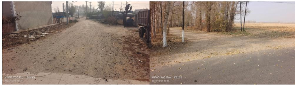
砂石路面主要病害为路拱不适、沉陷、车辙、坑槽、路面积水。
