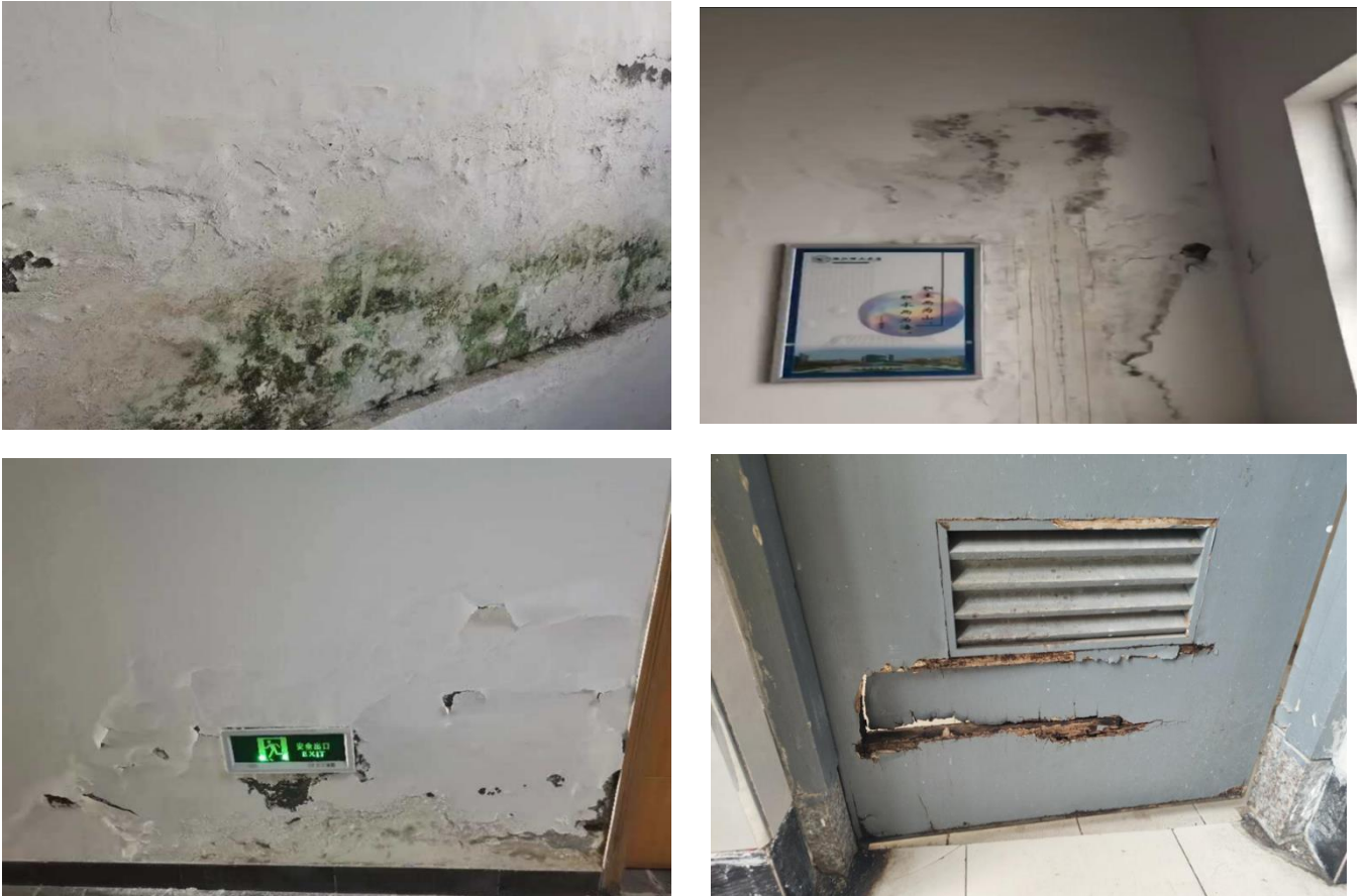
图 3-2 学生宿舍楼内部饰面情况图
