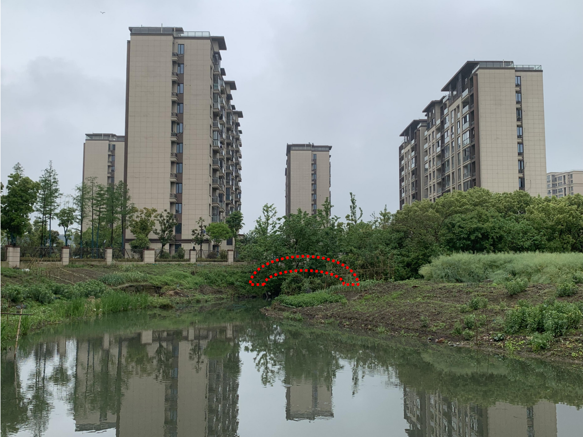
德清县康乾街道新民桥复建工程
