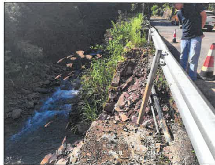
工点4 K4+470-K4+480现场照片
