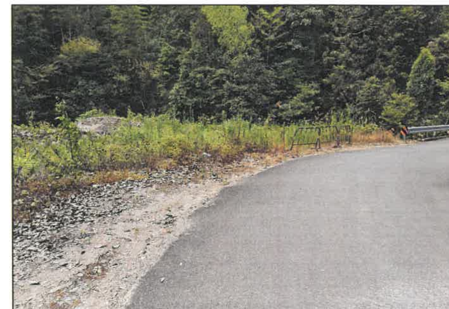
工点3 K5+230-K5+285现场照片
