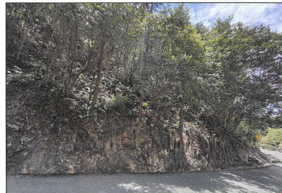
工点2 K2+000-K2+020现场照片
