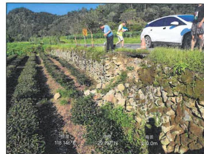
工点6 K16+900-K16+905现场照片
