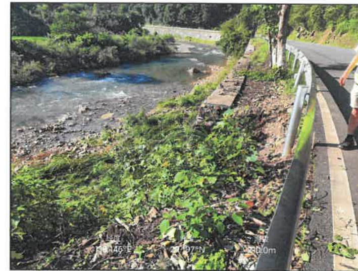
工点5 K16+500-K16+505现场照片
