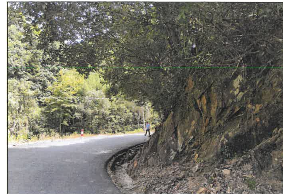
工点3 K5+130-K5+200现场照片
