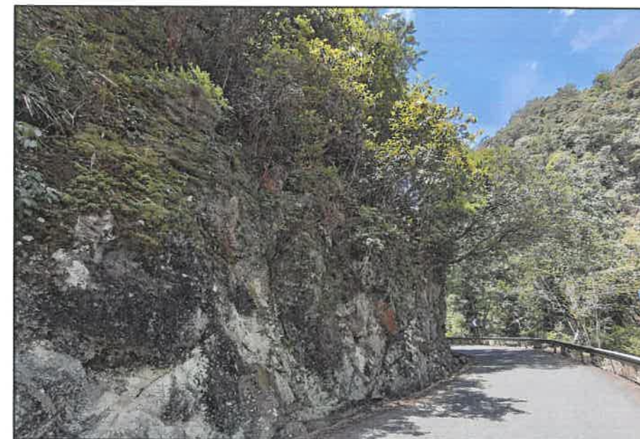
工点2 K2+040-K2+075现场照片
