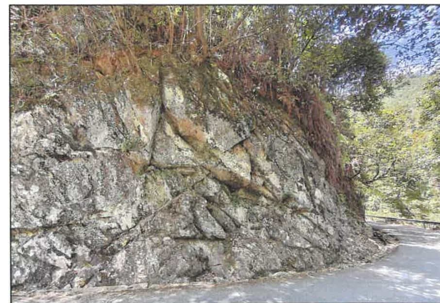
工点2 K2+020-K2+040现场照片
