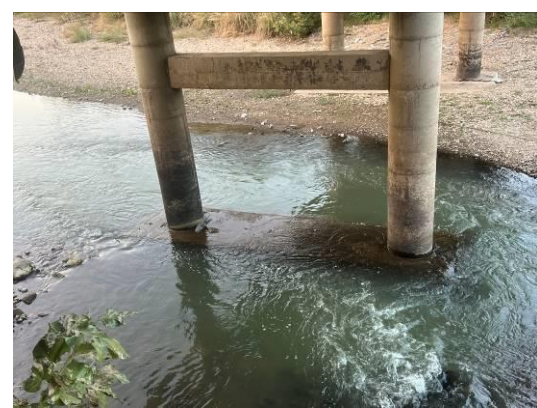
图 1-1-6 基础冲刷
