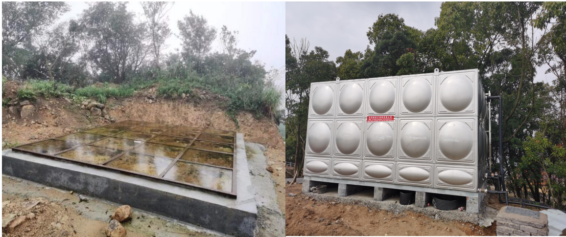
图 5-7 森林消防不锈钢组合式水箱
