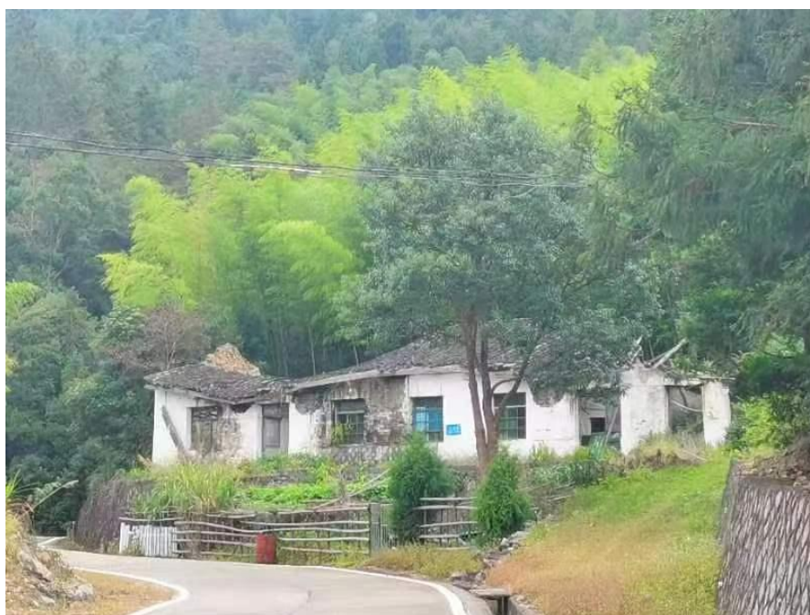
图 5-11 永嘉县改造物资储备库现场情况
