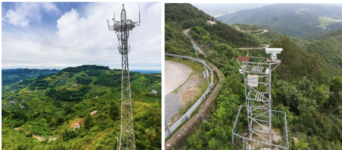
图 5-2 瞭望塔（台）基础设施
