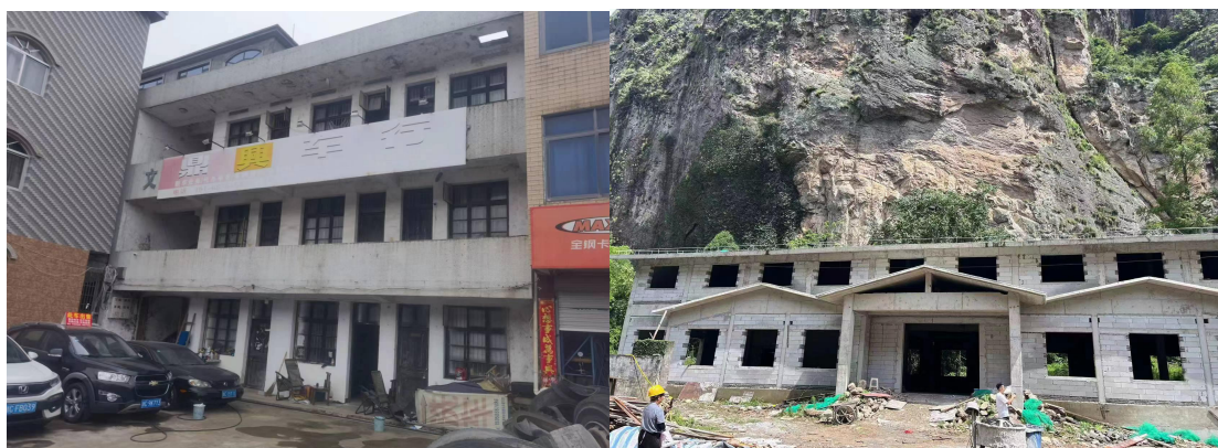
图 5-10 乐清市改造物资储备库现场情况
