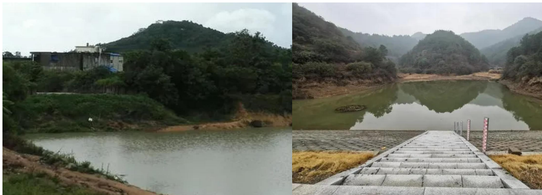
图 5-9 山塘、水库改造提升
