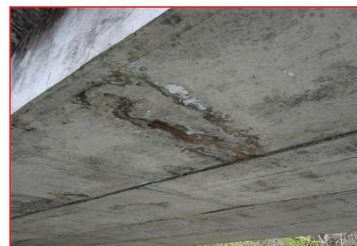
空心板钙化裂缝、锈胀露筋
