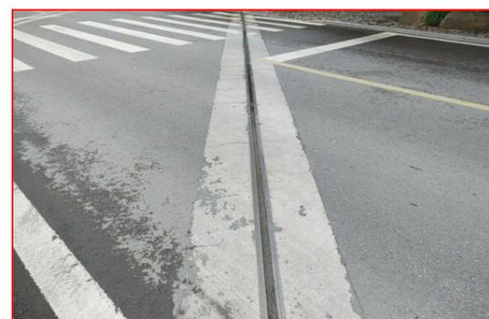
伸缩缝堵塞、橡胶条破损
