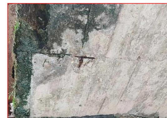
板底混凝土剥落、锈胀露筋
