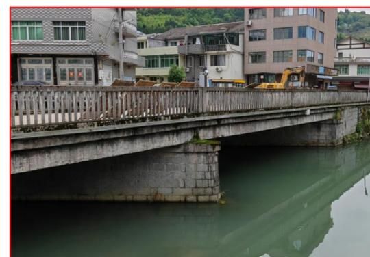
墩台砌体灰缝脱落、水侵害
