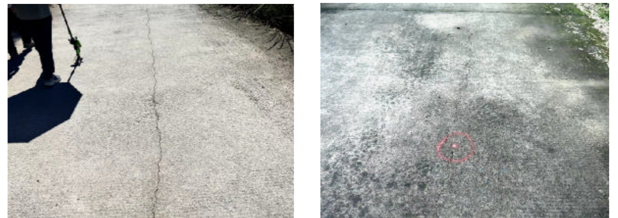
图3.1-2 典型裂缝病害
