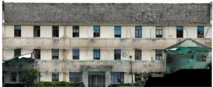
5号楼现状外立面
