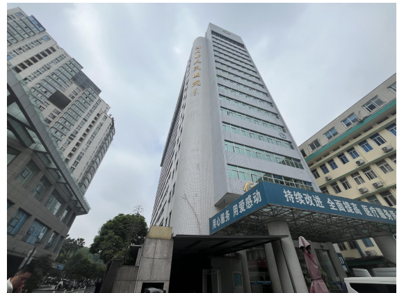
1号楼现状外立面
