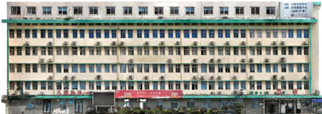
8号楼现状外立面
