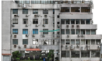
6号楼现状外立面
