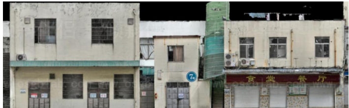
7号楼现状外立面
