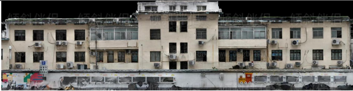
3号楼现状外立面
