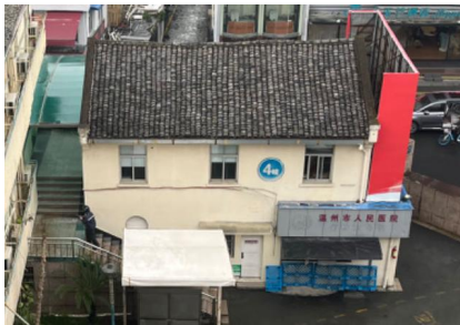
4号楼现状外立面
