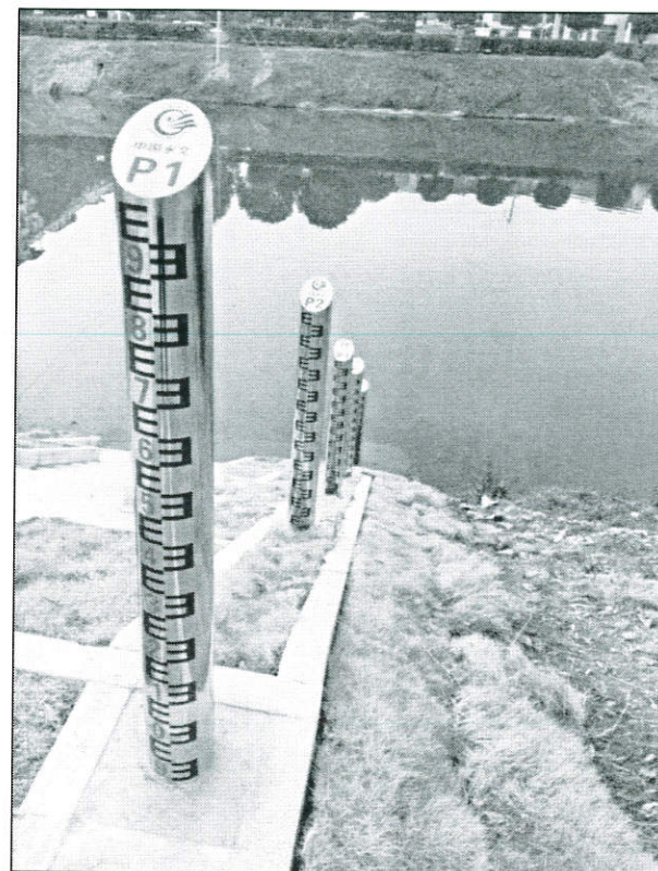
迎水坡坝面水位尺样式图
