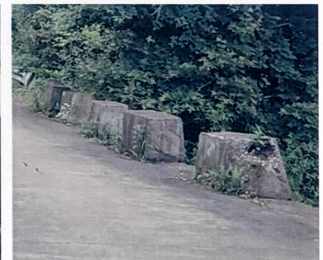
B线现状混凝土防撞墙
