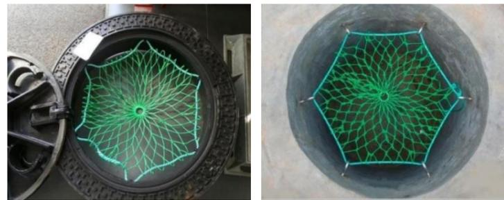
图 a 铸铁井盖检查井防坠网
