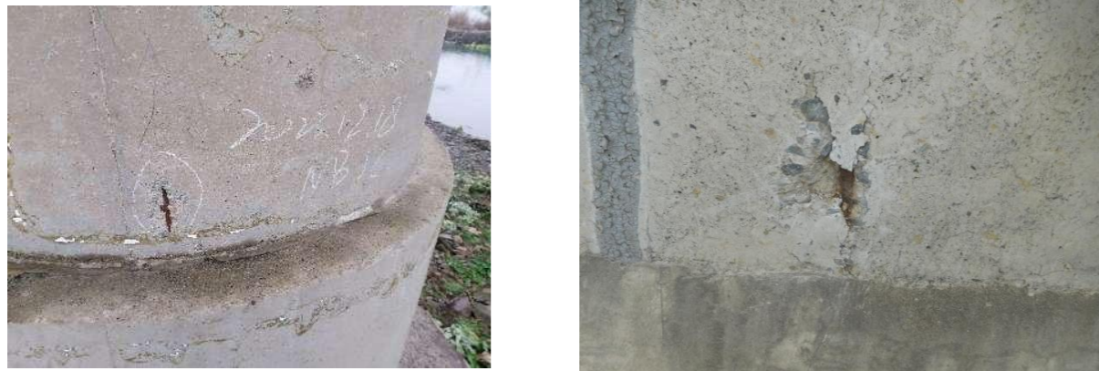
图 29 砼破损露筋
