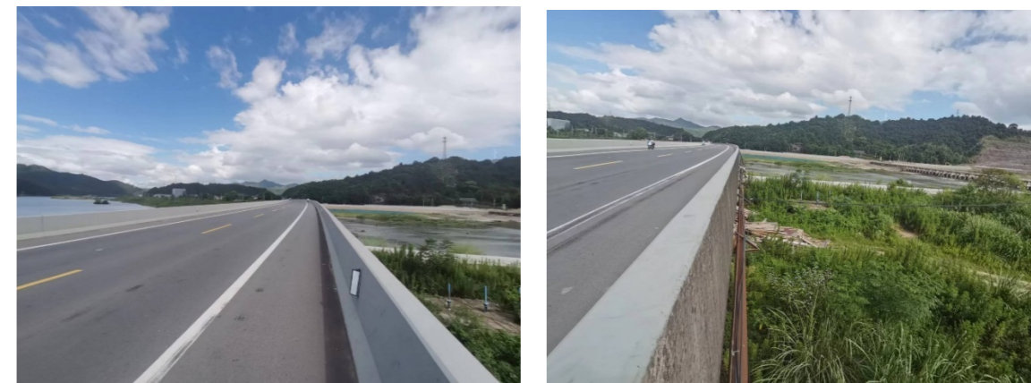
图 41 现状白溪大桥桥梁混凝土护栏示意图
