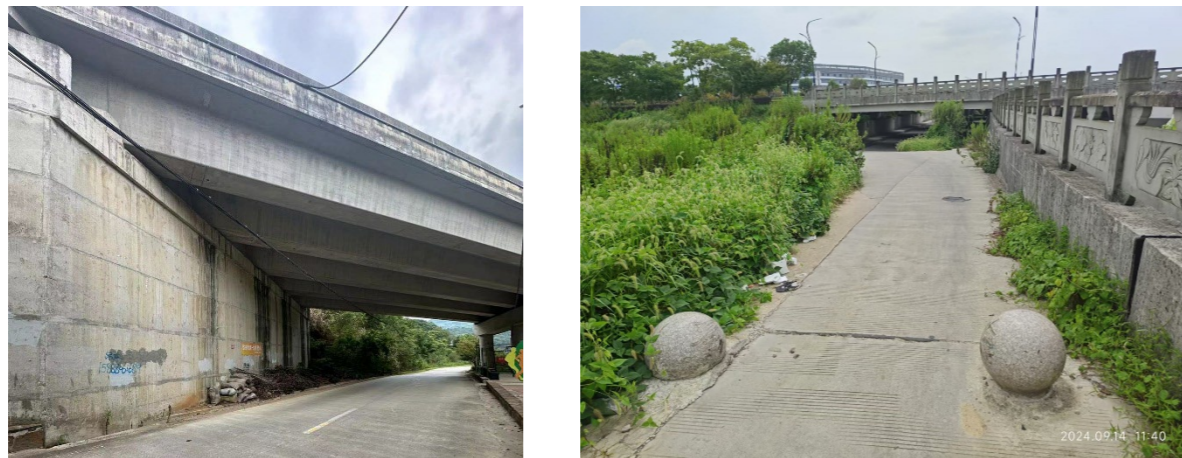
图 56 下穿通道情况示意图（左为杜岙大桥路段、右为力洋大桥路段）
