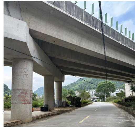
图 65 杜岙大桥排水设施
