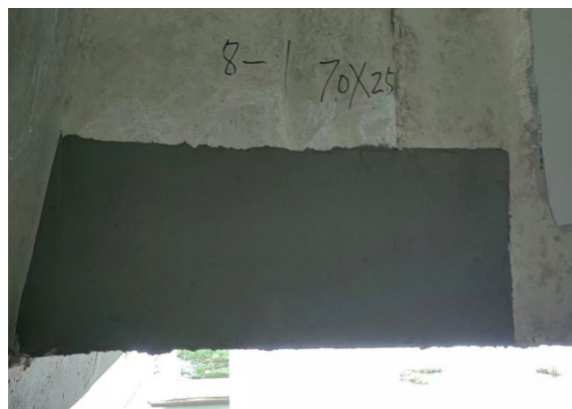
图 25 破损露筋修补
