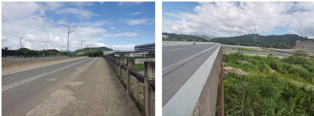
图 51 现状交通标线磨损情况示意图
