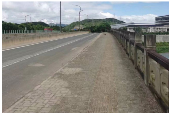
图 64 力洋大桥人行道现状
