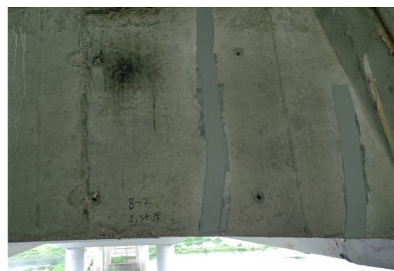
图 26 裂缝封闭
