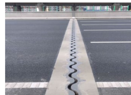
图 37 S 型 160 型伸缩缝
