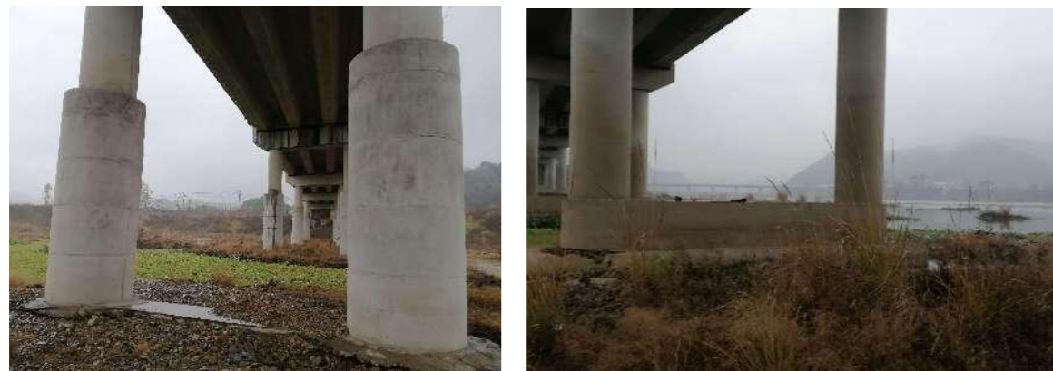
图 39 白溪大桥桩基现状
