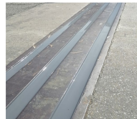
图 38 高弹性材料进行填缝
