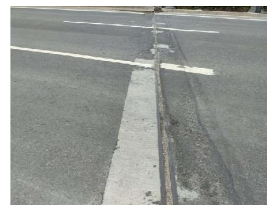
图 21 伸缩缝堵塞
