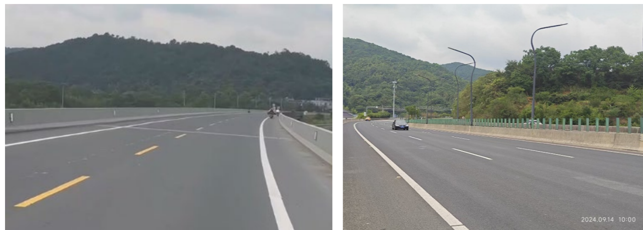
图 54 现状突起路标设置示意图
