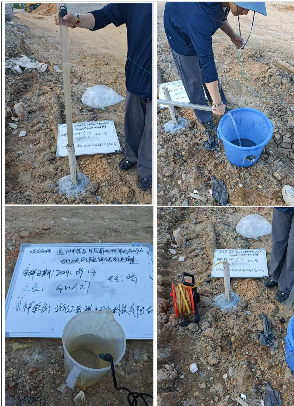
图 3.4-10 地下水井洗井与现场检测
