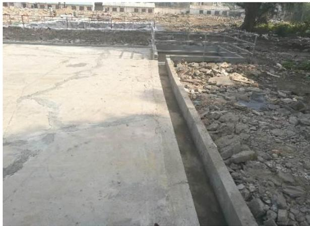
图 7.2-6 筛上物冲洗区排水沟和沉砂池
