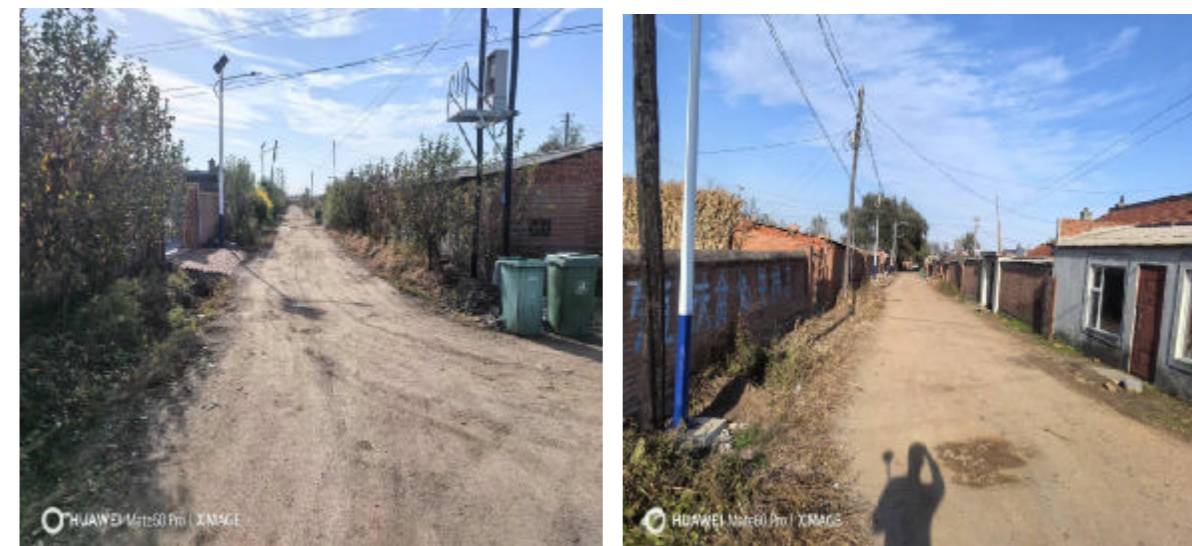
道路现状图片
