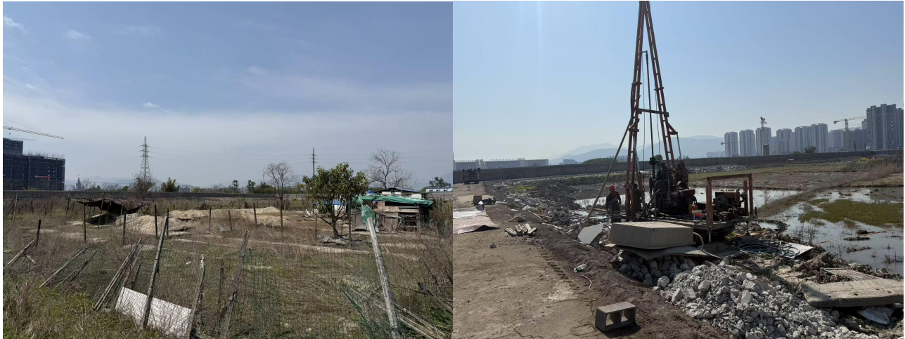
2.4.1 勘察期间照片(场地北侧，镜头朝西) 2.4.2 勘察期间照片(场地北侧，镜头朝东)
