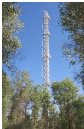
建议拉线塔（基站和天线安装位置）
