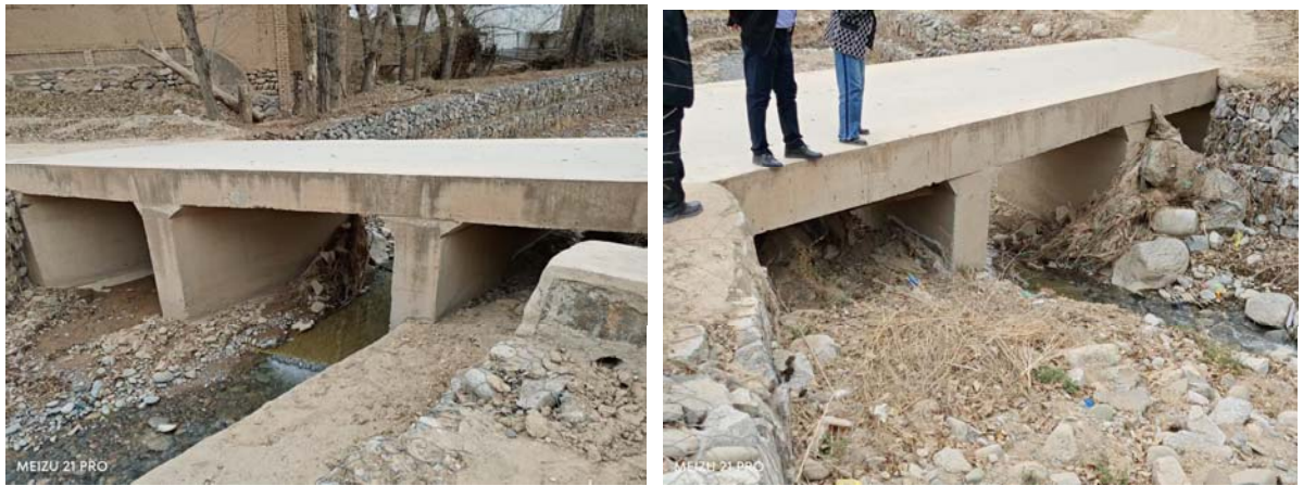
桥梁道路（增加护栏）
