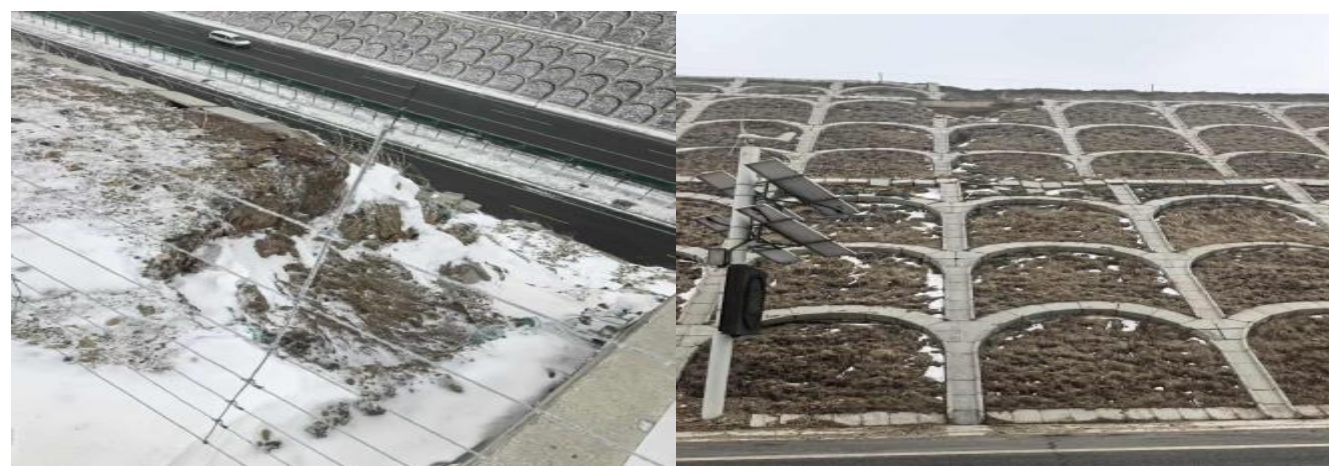
(10) G109 线 K2002+150-K2002+157 处道路左侧（下行线）拱形骨架护坡破损, 宽度 7m, 平均高度 3m。
