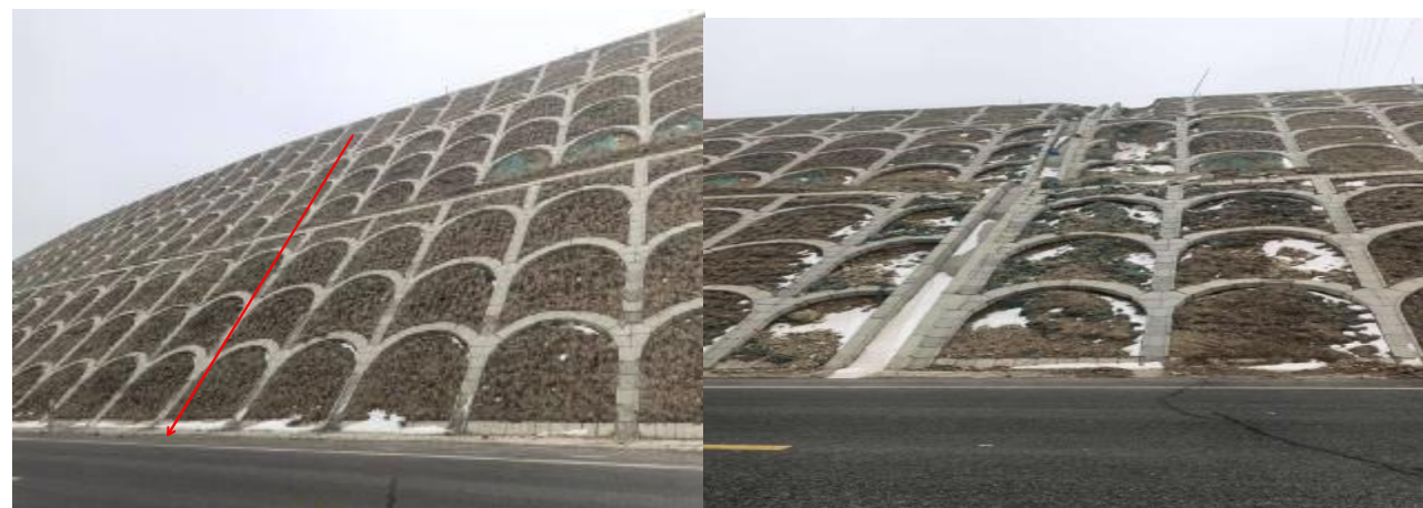
(9) G109 线 K2002+100-K2002+107 处道路左侧（下行线）拱形骨架护坡破损,宽度 7m, 平均高度 24m。
