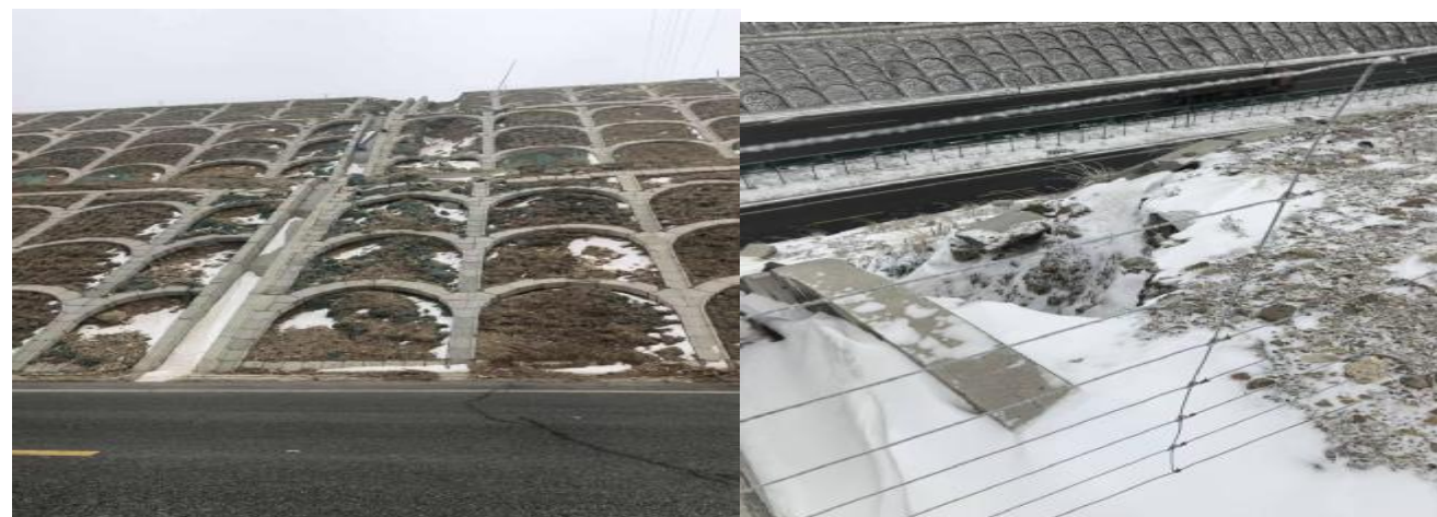
(10) G109 线 K2002+150-K2002+157 处道路左侧（下行线）拱形骨架护坡破损, 宽度 7m, 平均高度 3m。
