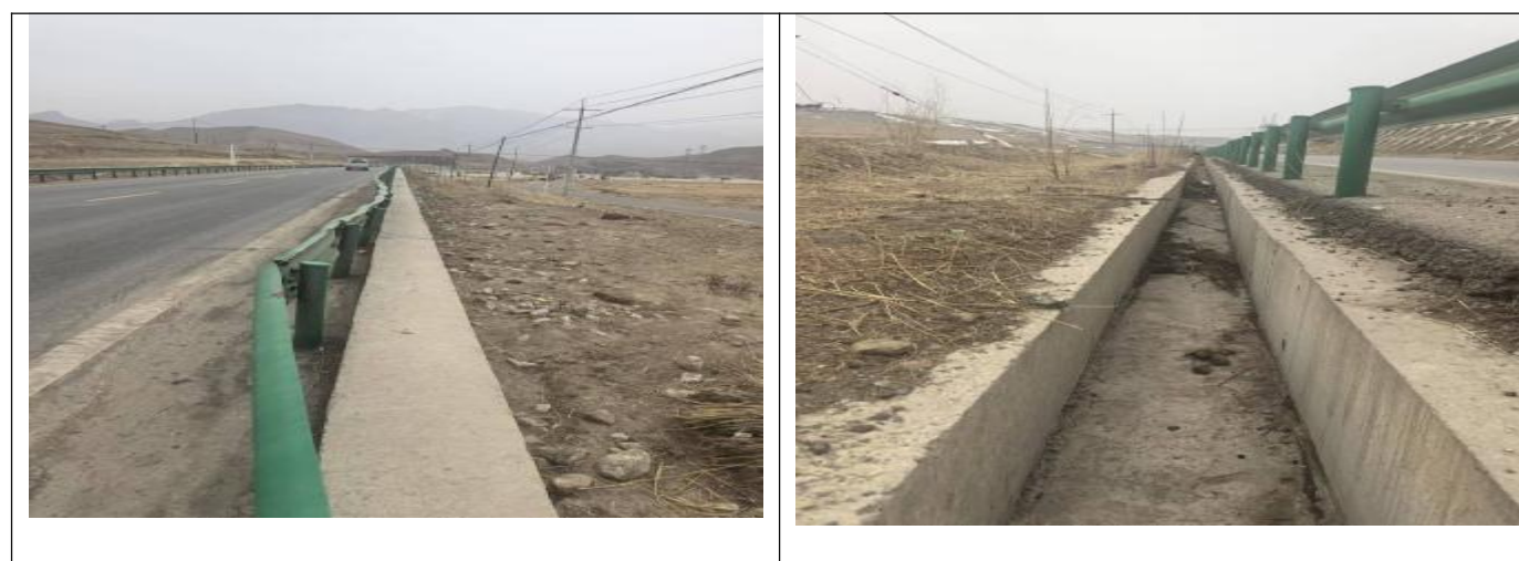
(9) G109 线 K2002+100-K2002+107 处道路左侧（下行线）拱形骨架护坡破损,宽度 7m, 平均高度 24m。
