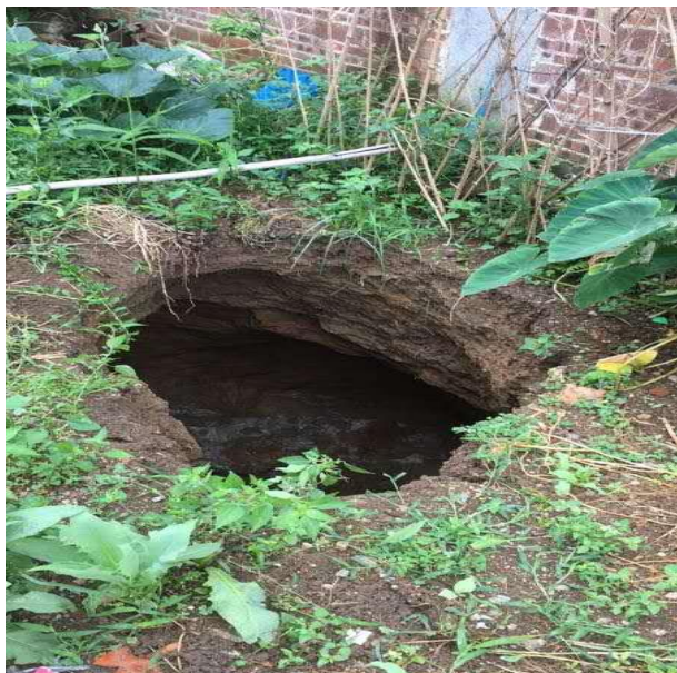
照片 2-11 TX7 塌陷点近景
