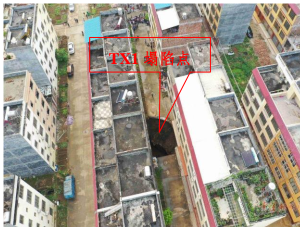
照片 2-1 TX1 塌陷点位置及周边情况
