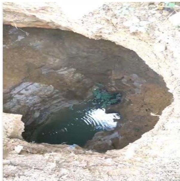
照片 2-12 TX7 塌陷点内景
