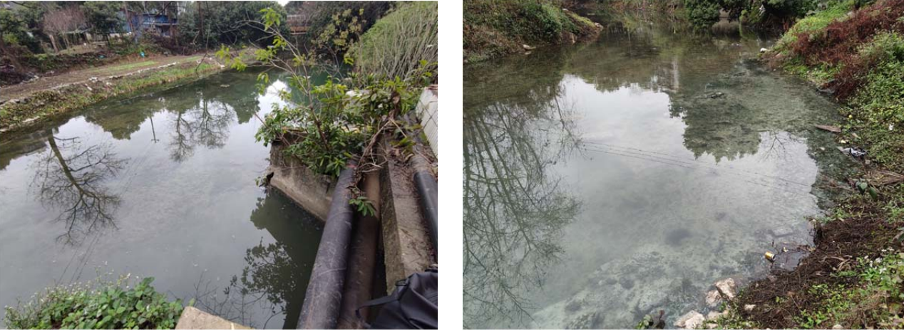
铁西片区雨污合流排水渠实拍图
