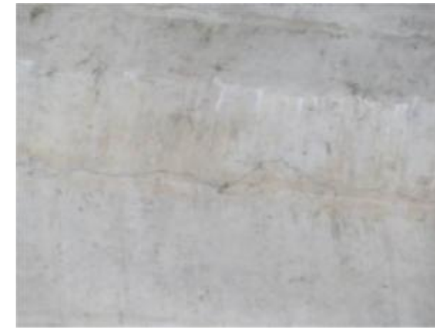
32-1#箱梁右侧翼缘板纵向裂缝
