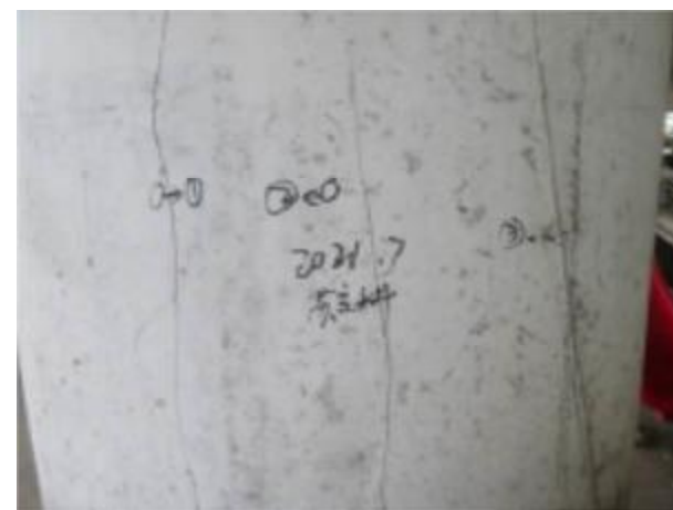
7-2#立柱小桩号面竖向裂缝
