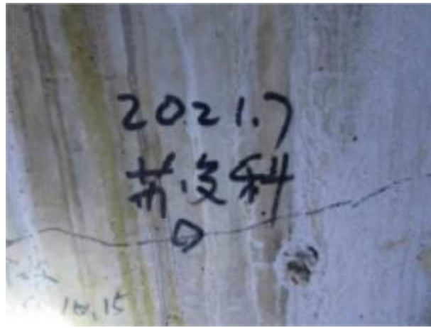
箱室内23#墩顶横隔板水平裂缝
