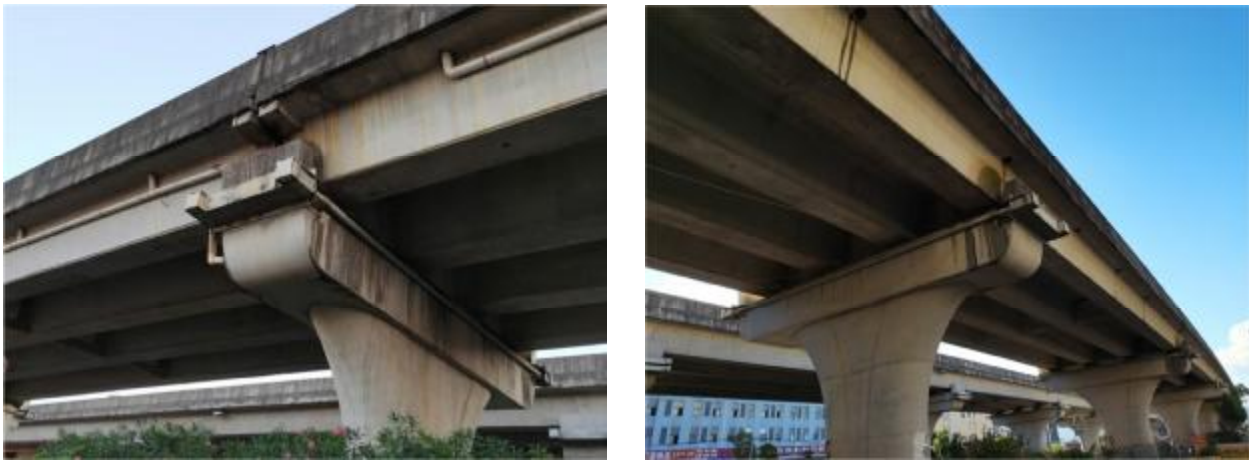
外部钢垫板及保护罩出现锈蚀
