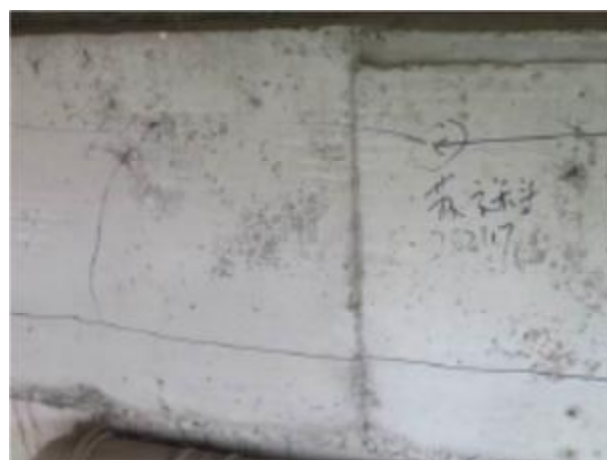
29#盖梁大桩号面水平裂缝
