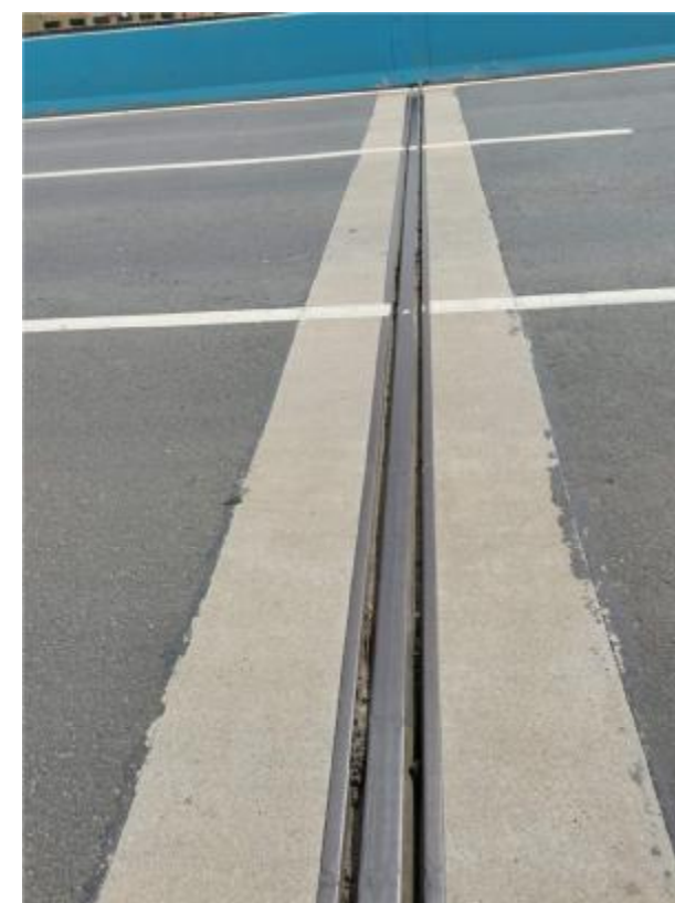
伸缩缝橡胶条破坏
