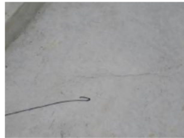
20#墩身大号桩侧斜向裂缝
