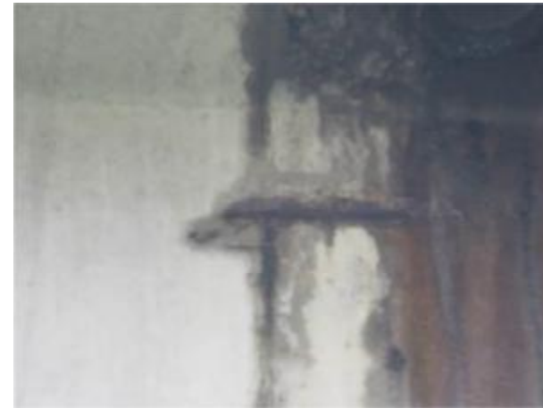
46-4#箱梁右侧翼缘板露筋
