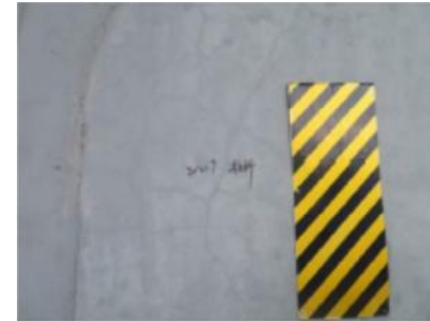
23#墩身大桩号侧网状裂缝
