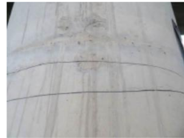
45#墩身左侧面环向裂缝
