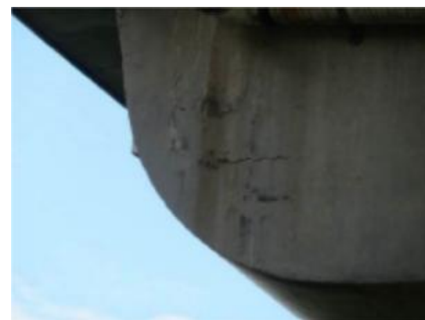
30#盖梁大号桩侧钢筋锈胀
