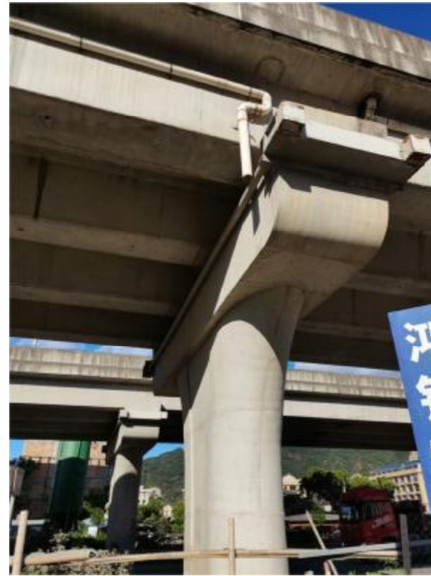
落水管堵塞未接地
