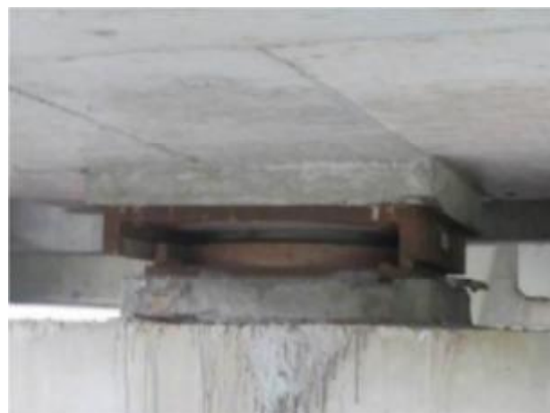
24-24-2#支座钢垫板轻微锈蚀
