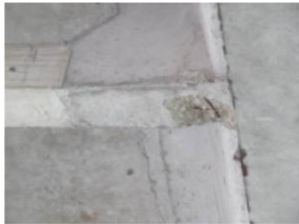
50-2-2#横隔板底部破损
