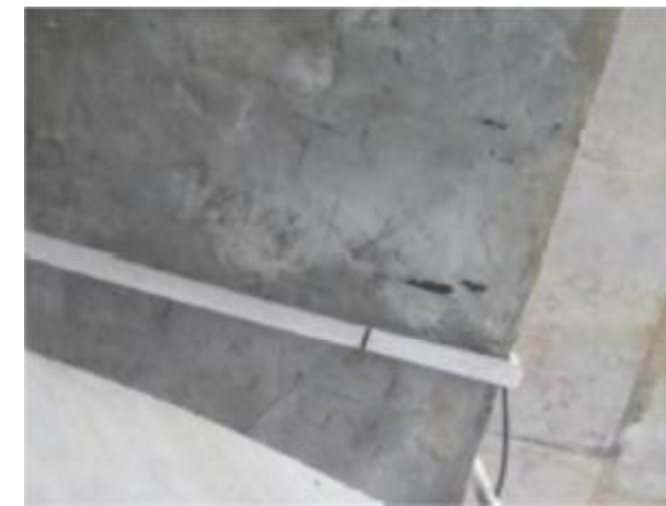
第25 跨箱梁底板露筋
