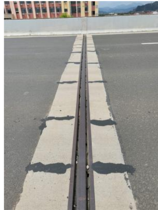
伸缩缝橡胶条破坏
