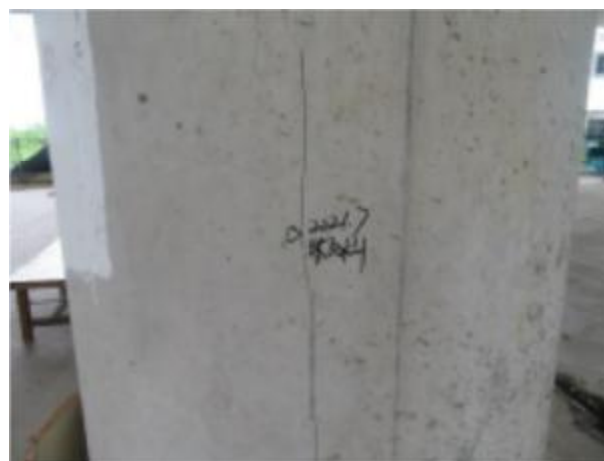
6-1#立柱右侧面竖向裂缝
