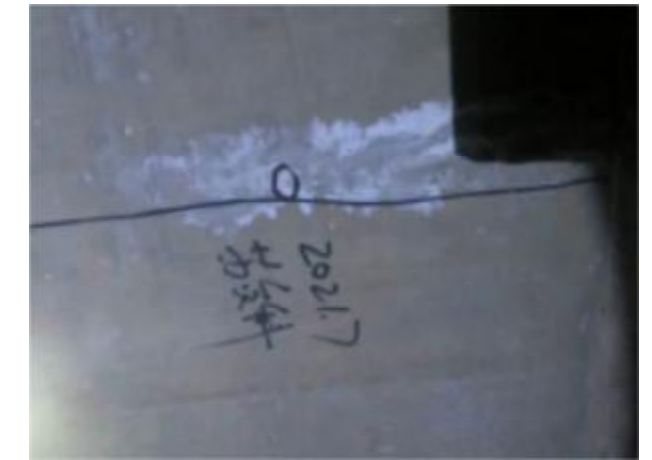
第23 跨箱梁顶板横向裂缝
