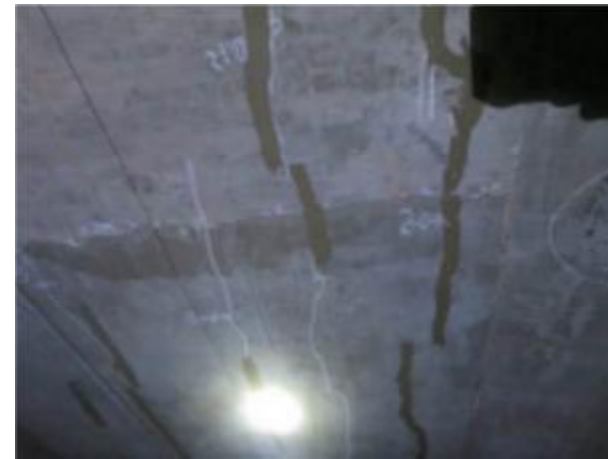
第24 跨1#箱室内顶板裂缝已修补
