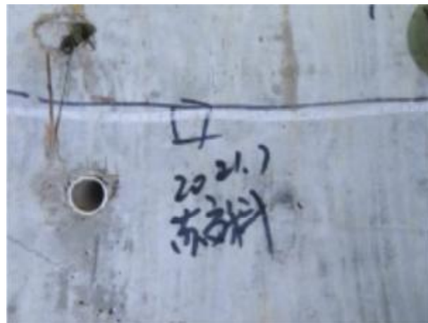
第24 跨1#箱室内左腹板水平裂缝
