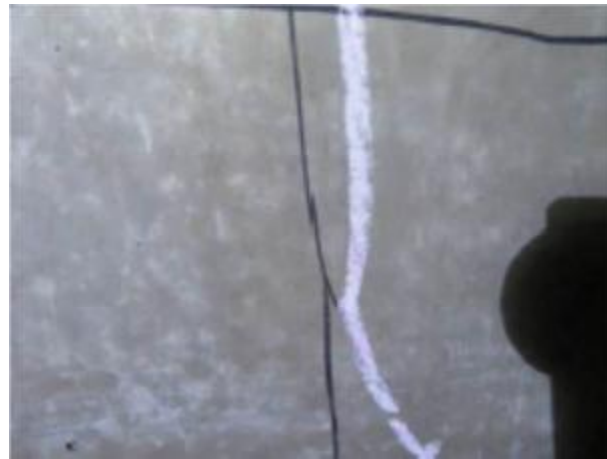
第24 跨1#箱室内顶板纵向裂缝
