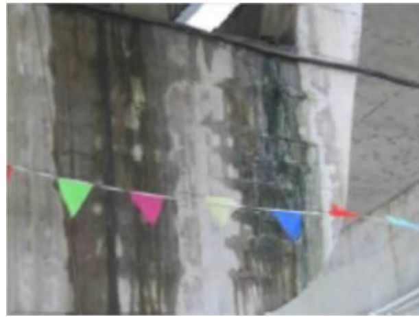
6#盖梁大桩号侧钢筋锈胀
