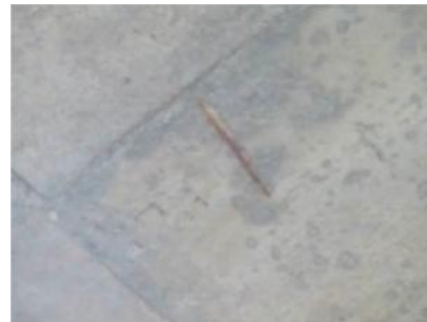
第25 跨箱梁翼板露筋
