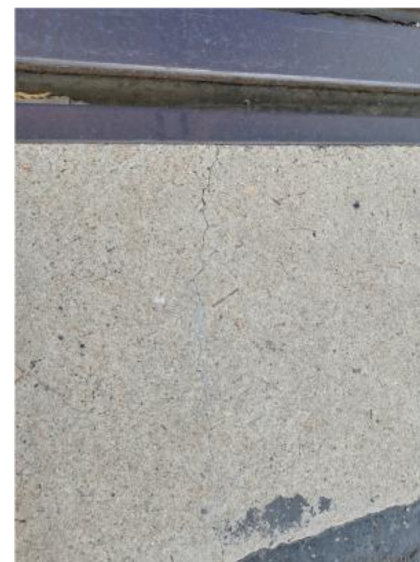
伸缩缝锚固区纵向开裂
