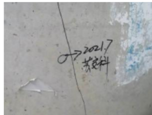
13-3#立柱左侧面竖向裂缝
