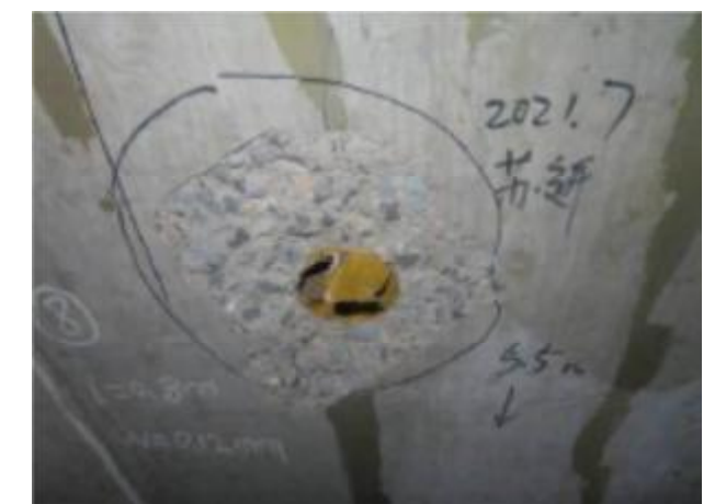
第24 跨箱梁顶板破损
