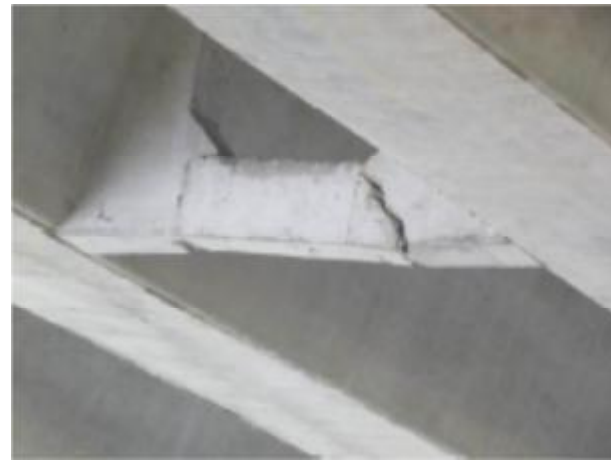
4-2-3#横隔板底部开裂
