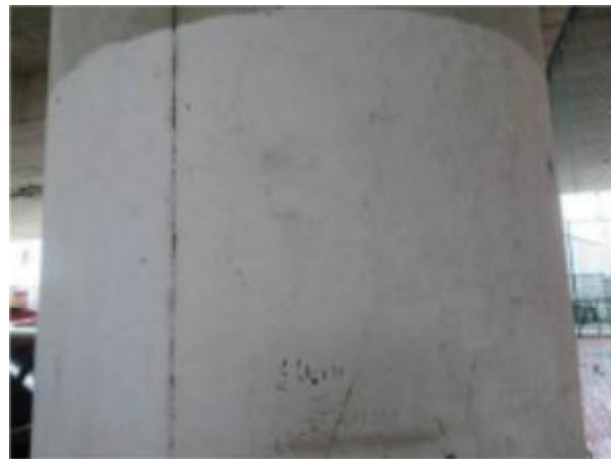
立柱右侧面涂层网裂
