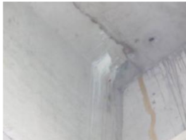
74-2#箱梁左侧翼缘板斜向裂缝，伴有析白
