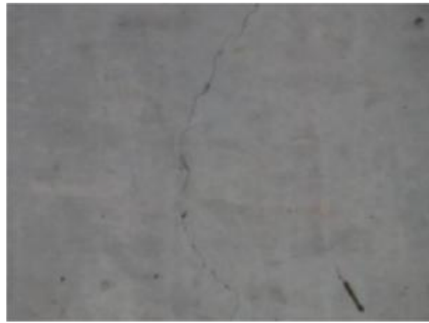
3-1-3#横隔板大桩号侧竖向裂缝
