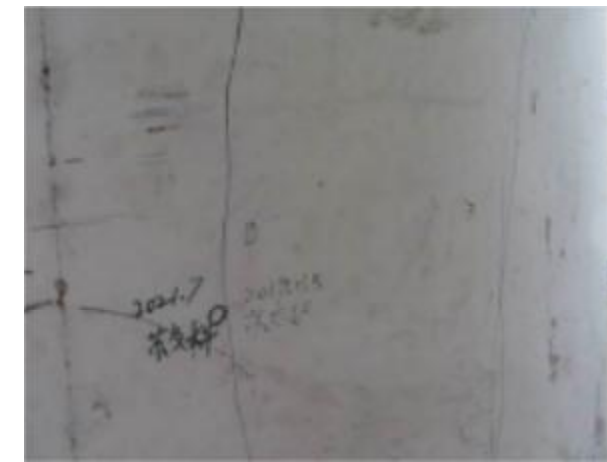
8-4#立柱右侧面竖向裂缝
