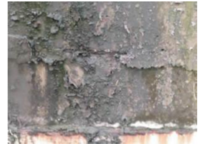
76#盖梁左侧面钢筋锈胀
