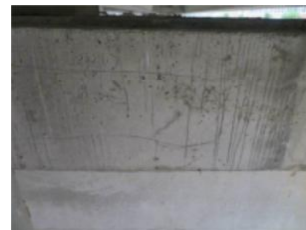
87#盖梁大桩号侧水平裂缝
