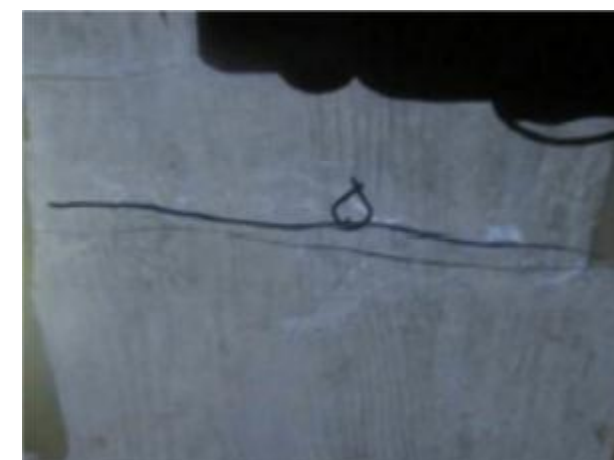
第24 跨箱梁顶板横向裂缝
