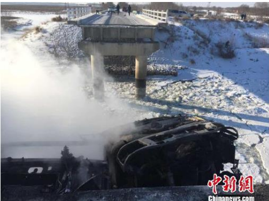
塔哈河大桥坍塌事故
