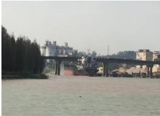
珠海市莲溪大桥船撞局部坍塌
