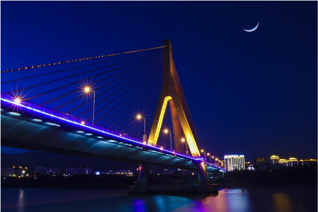
图 1-1 临海大桥桥梁概貌
