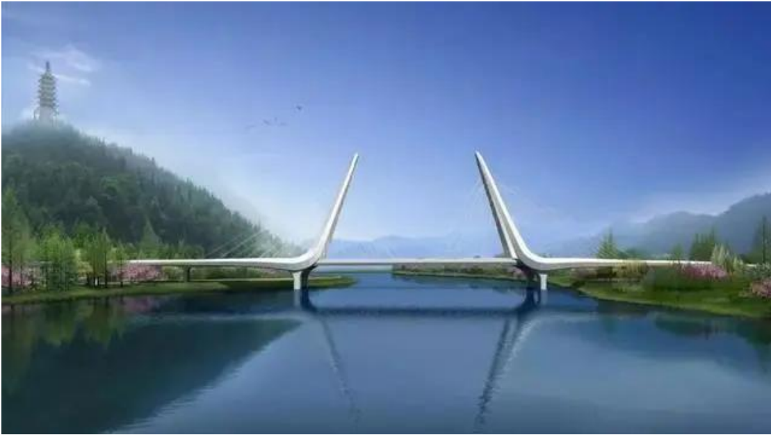
图 1-5 伏龙大桥桥梁概貌
