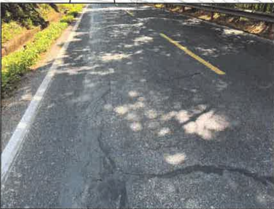
K102+330 沉陷、纵缝、横缝
