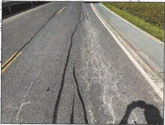
K8+600 沉陷、龟裂、纵缝
