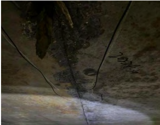
图 1.3-15 7#空心板剥落
