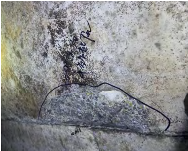
图 1.3-14 5#空心板剥落
