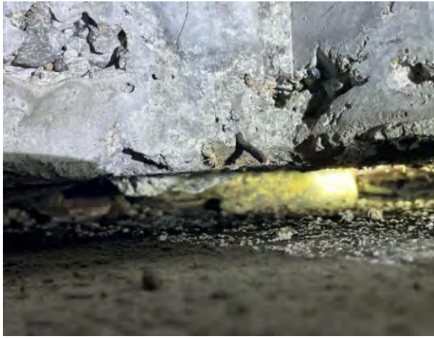
图 1.3-16 0-6#支座剪切变形
