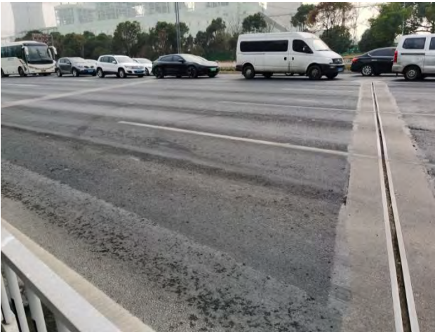
图 1.2-6 东村桥正面照片
