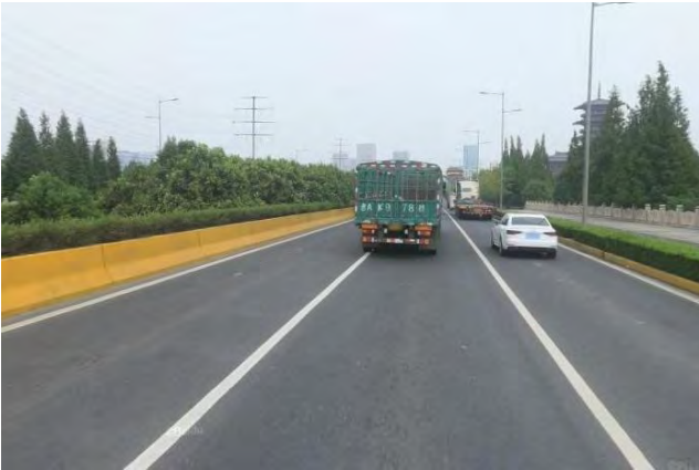
图 1.2-6 杨湾大桥正面照片
