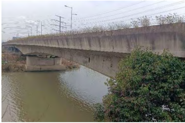
图 1.2-7 杨湾大桥立面照片
