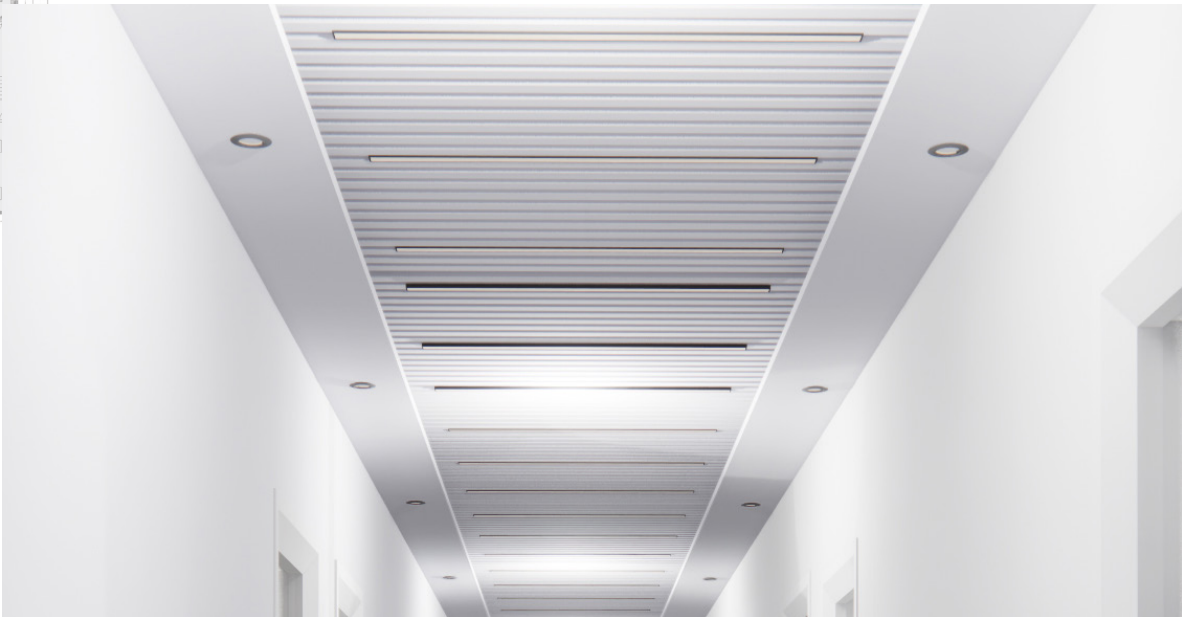
1 走廊吊顶 形式一
