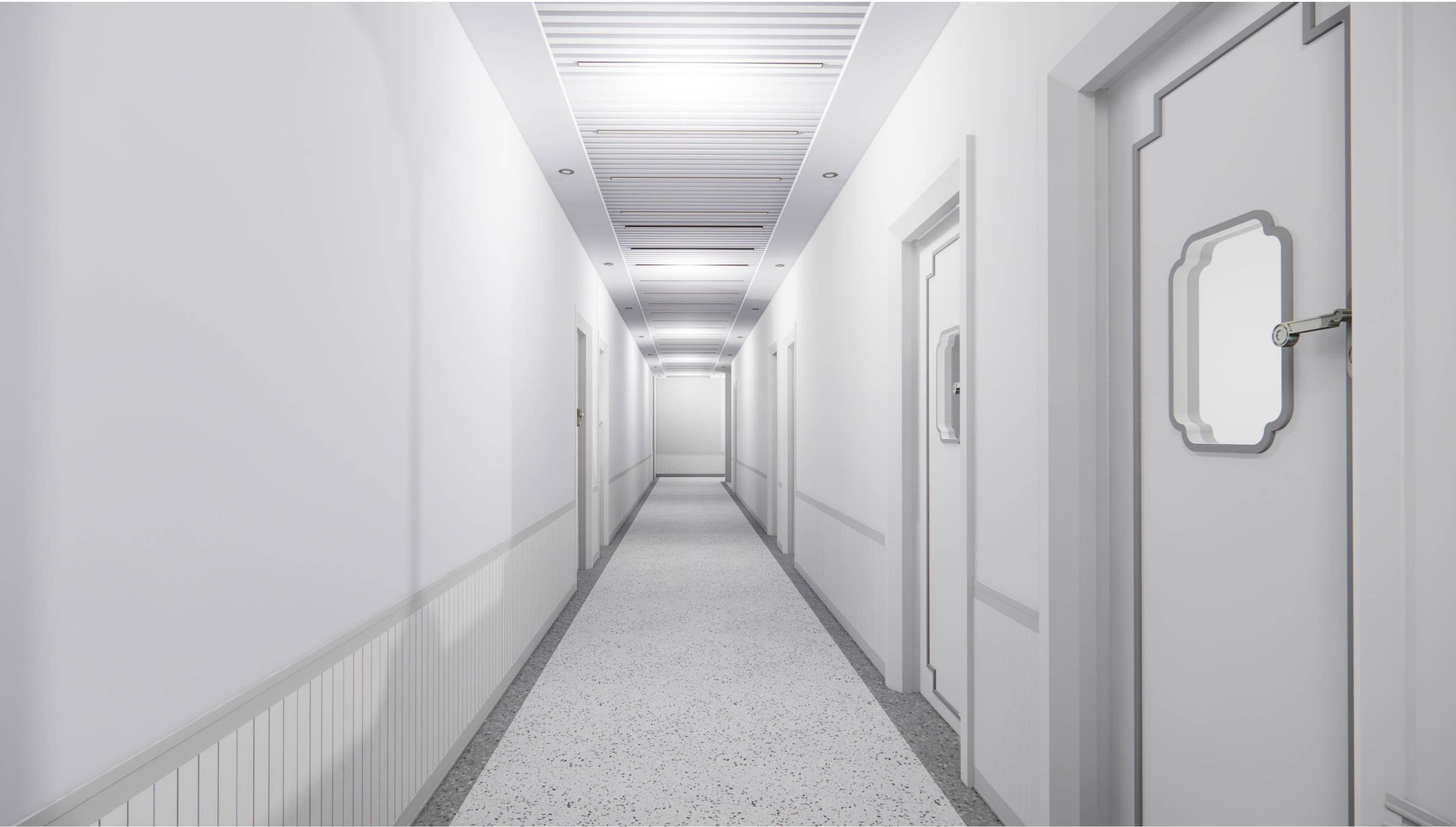
一楼餐厅内廊吊顶
