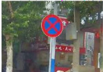
禁停标志拆除，标志板利旧与单行路标志共同附着路灯杆（绿化修剪）
