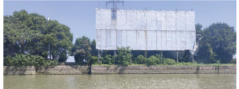
图2-1 浆砌块石现状护岸
