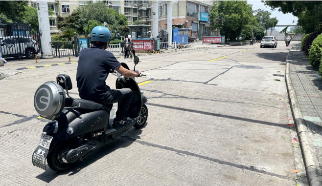
井口板块破损
