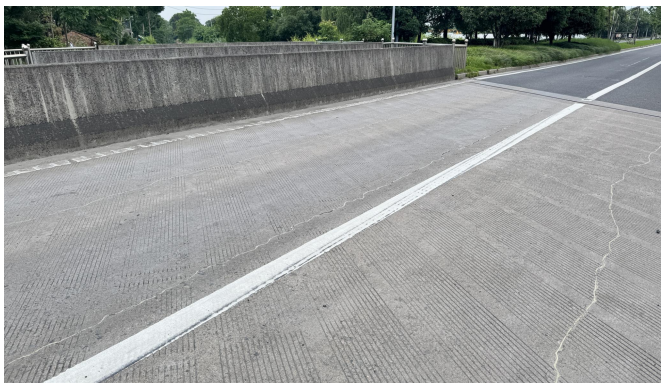
桥面系破损
