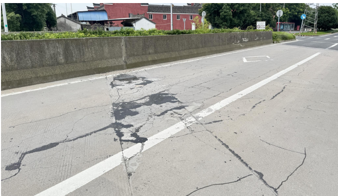
桥面系破损
