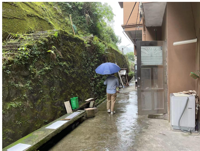
照片 17 屋后挡墙整体稳定
