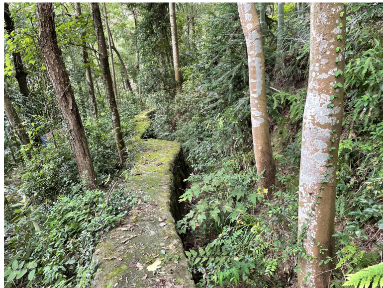
照片 17 山坡截水沟
