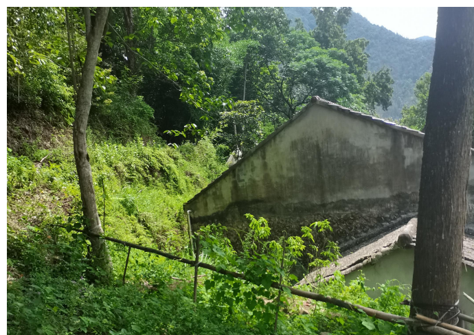
照片 18 屋后边坡稳定，无裂缝、滑塌等现象
