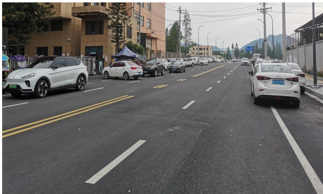
兴达路西段已完工路段现状照片
