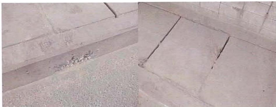
K519+783 左侧检修道路缘破损
