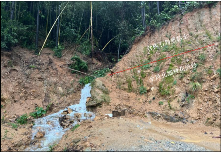
照片 3.4 A-B 段边坡岩土体组
