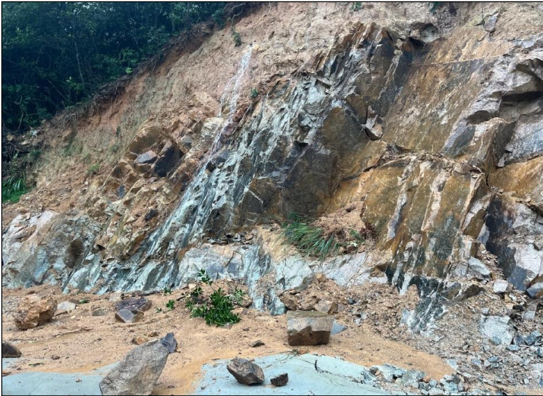
照片 3.10 D-E 段（瑞宏工业宿舍后侧段边坡）崩塌特征
