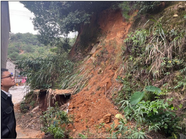
照片 3.9 C-D 段（瑞宏工业厂房后侧边坡段）崩塌特征
