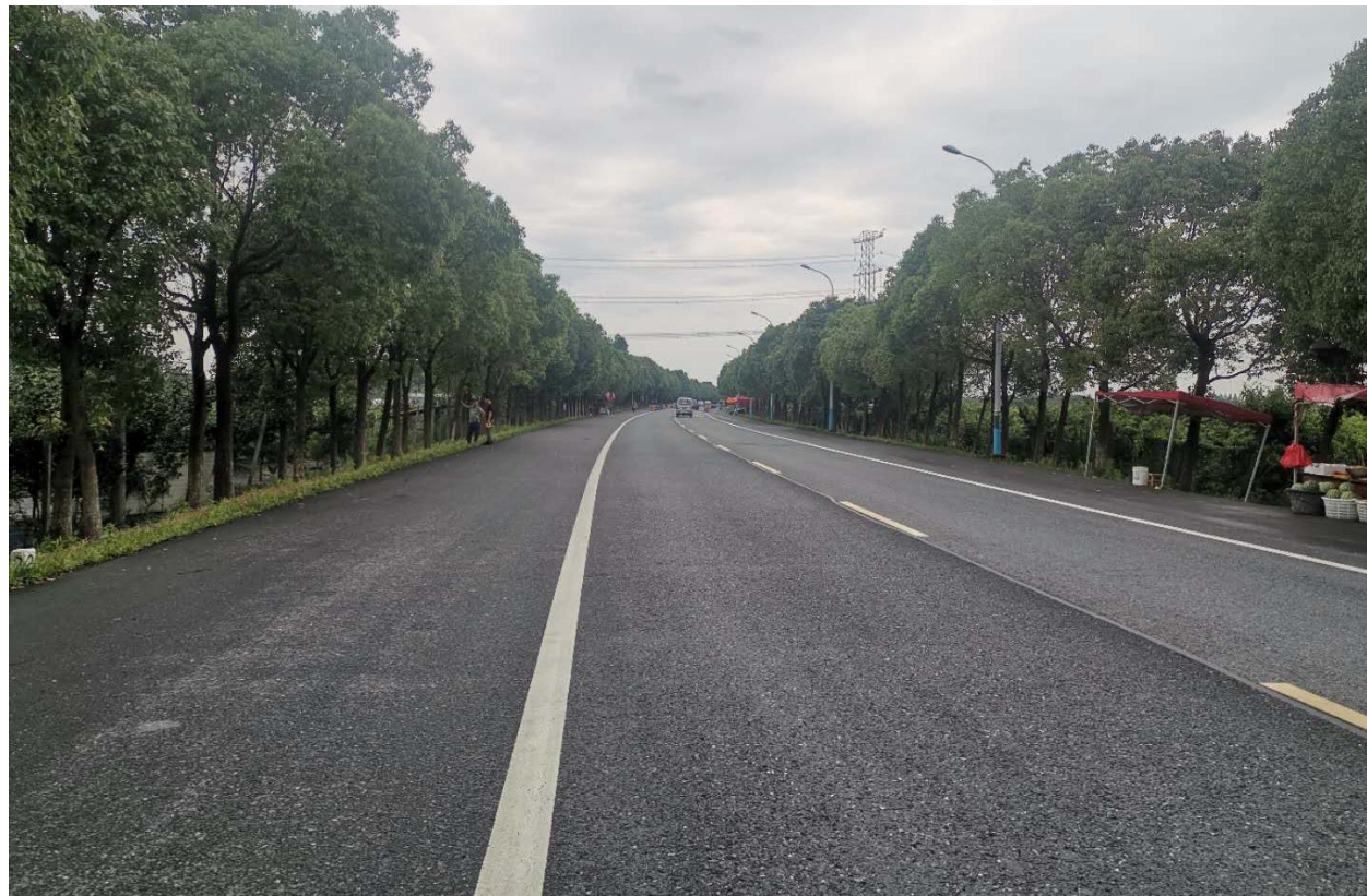
新盛线点位处现场照片
