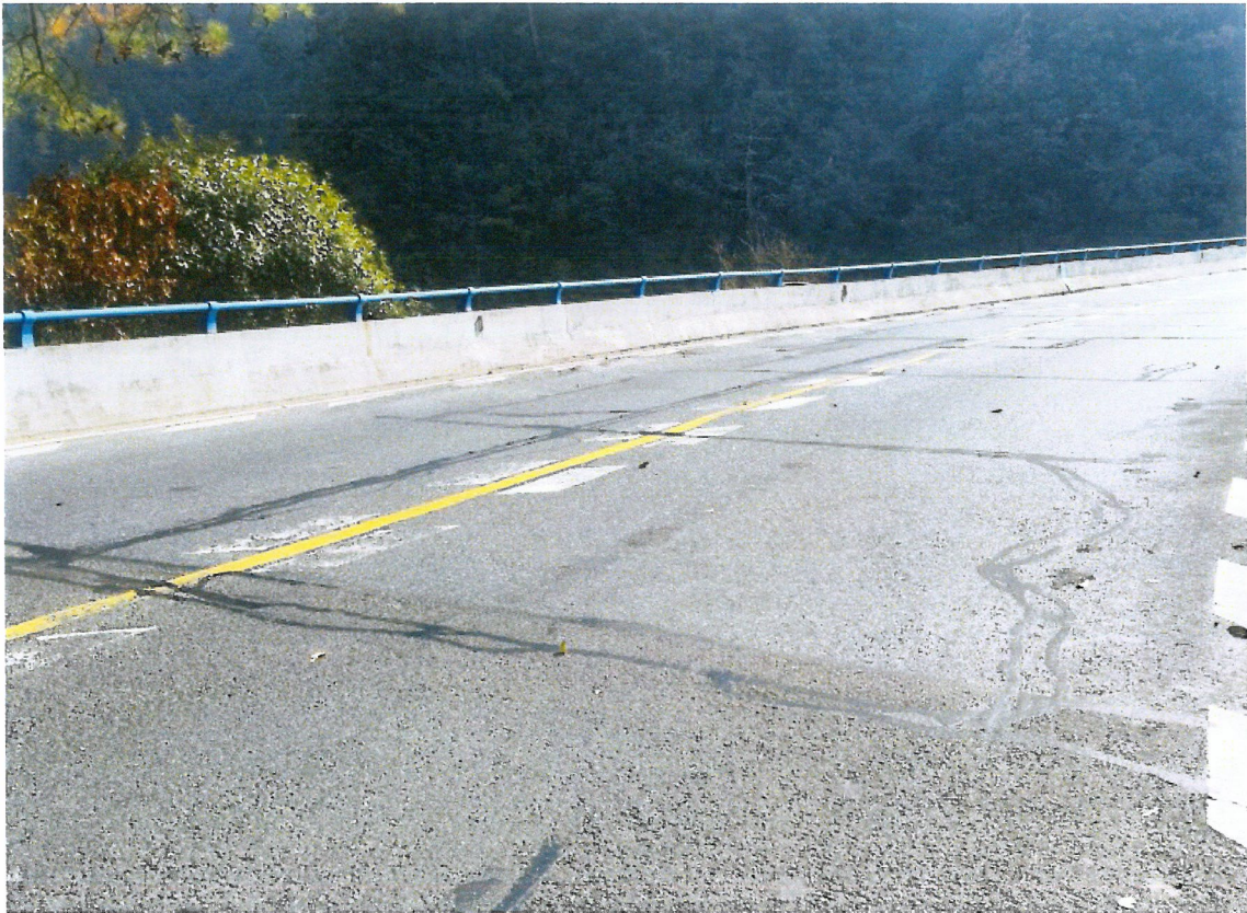
路面铺装裂缝、车辙
