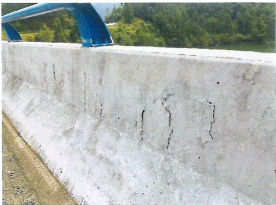
护栏锈胀露筋
