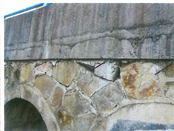
拱上侧墙破损
