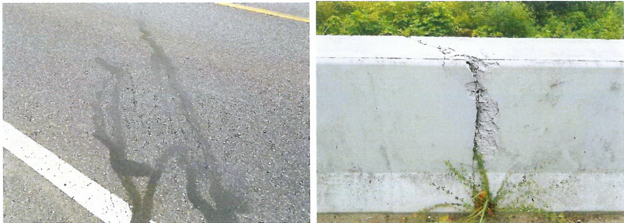
桥面铺装裂缝
