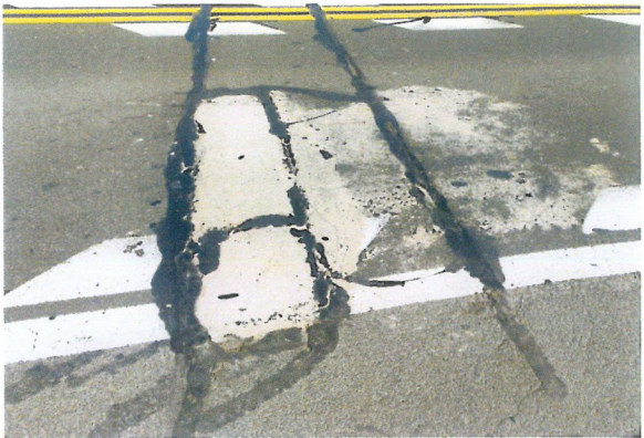
桥面铺装破损
