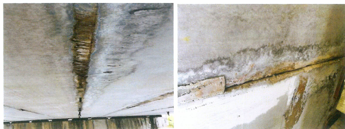
铰缝勾缝脱落
