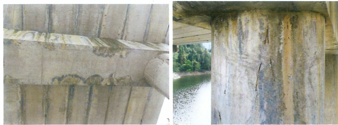
盖梁底面锈胀露筋
