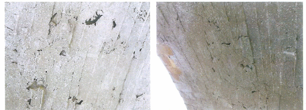
主拱圈拱顶喷料空洞
