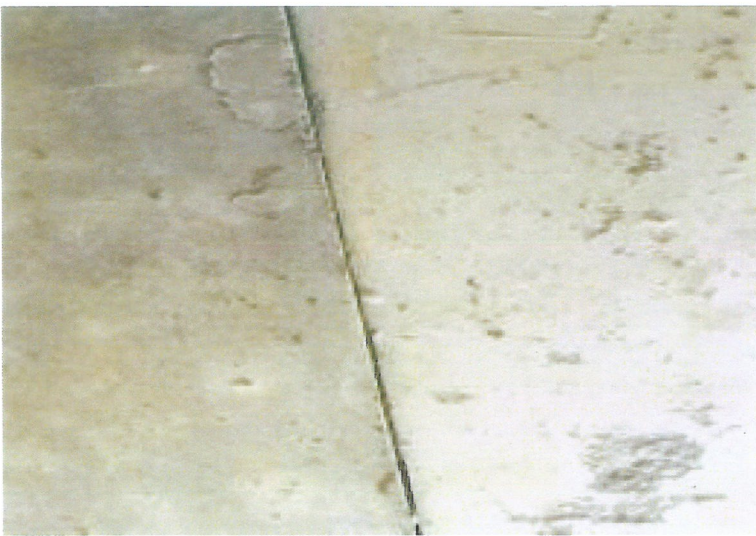
铰缝勾缝脱落
