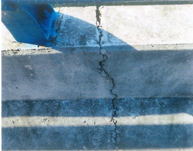
护栏 U 形裂缝
