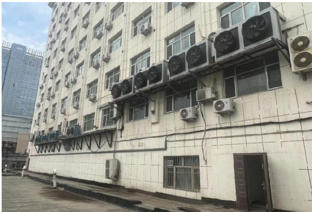
室外机安装现状
