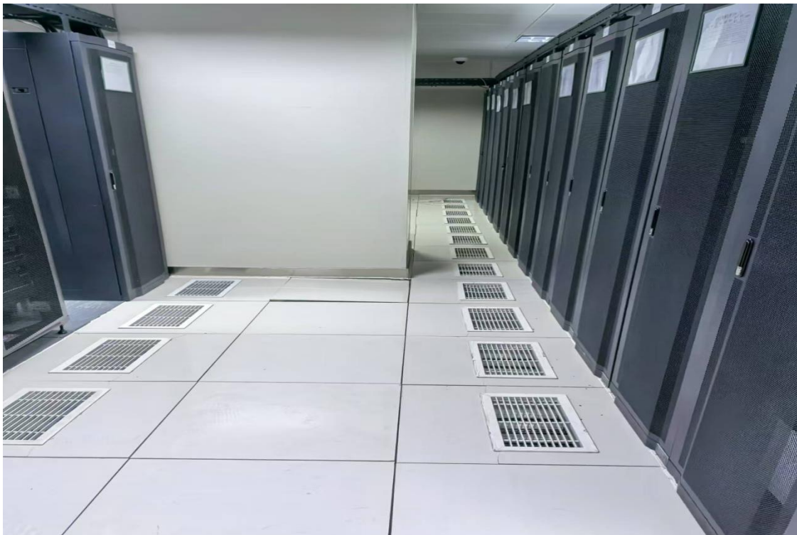
机房地板现状
