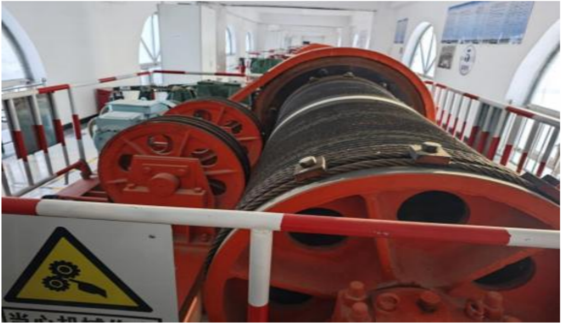
图3 启闭机现状一
