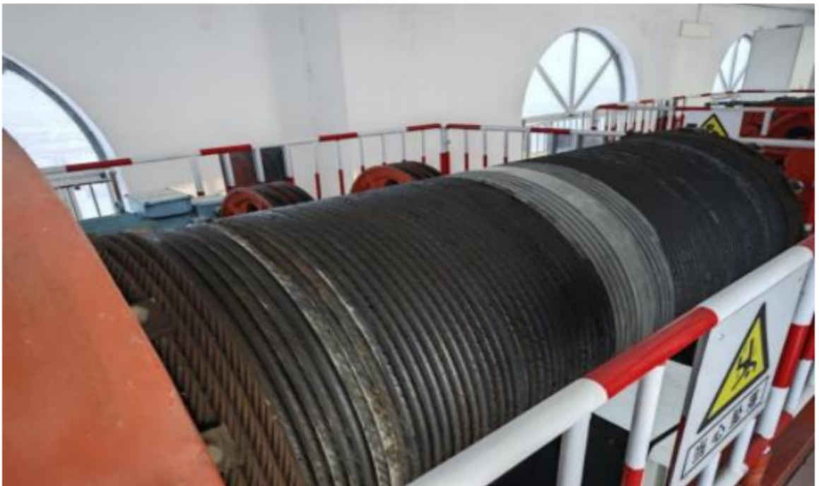
图4 启闭机现状二
