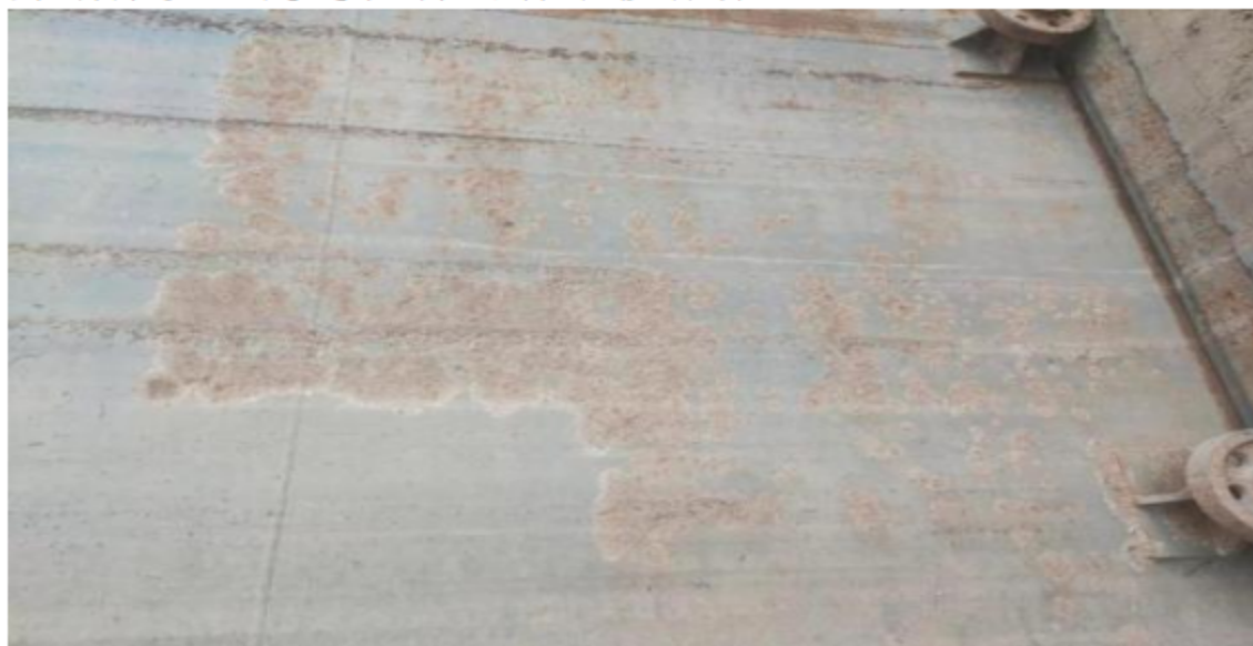
图1 溢洪道闸门现状一
