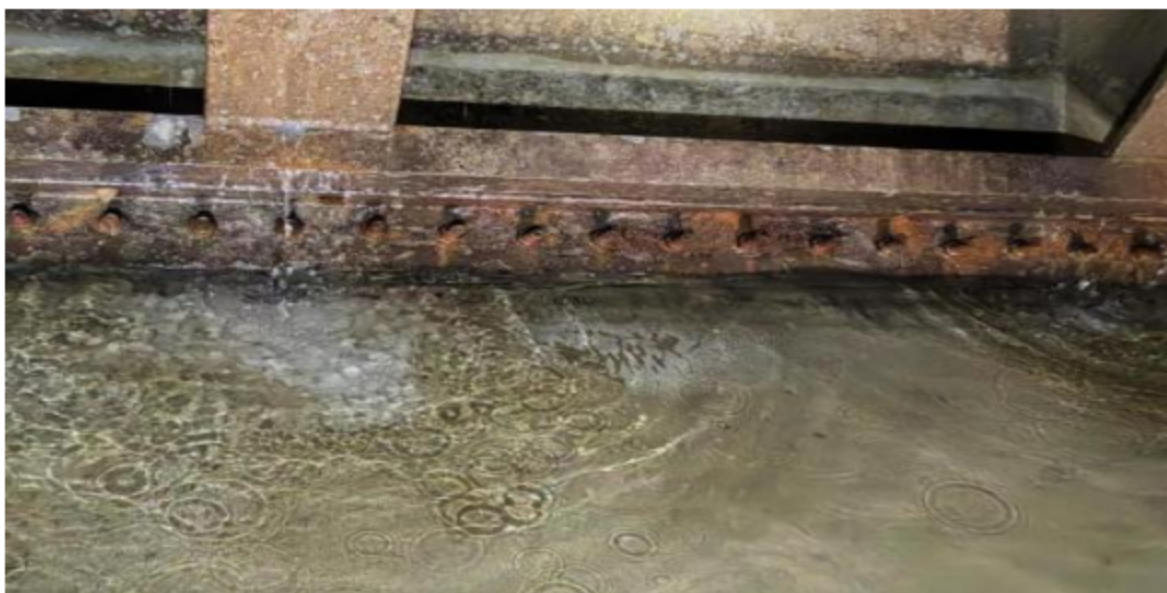
图5 泄洪洞南闸现状
