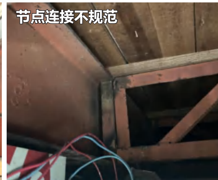
节点连接不规范且腐蚀严重
