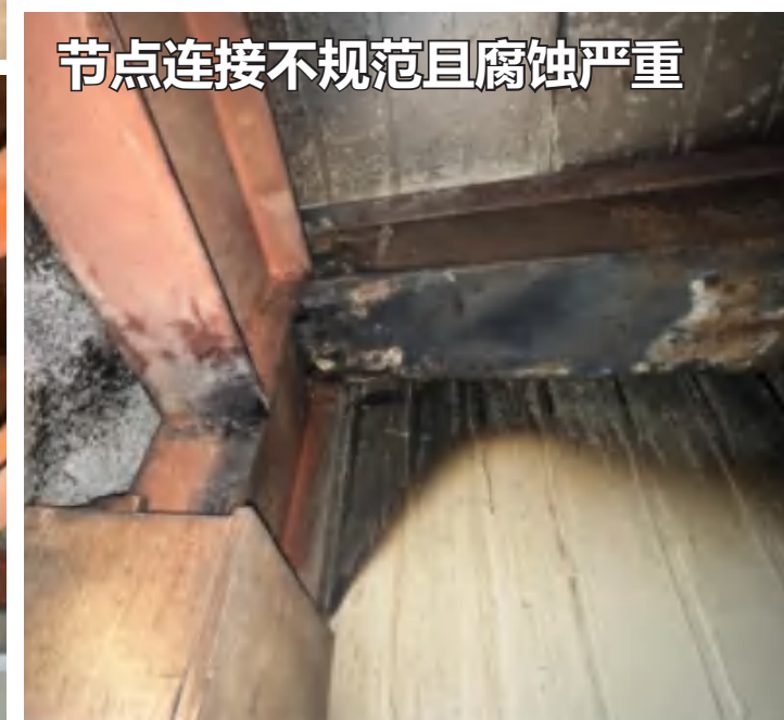
小型桁架次梁锈蚀
