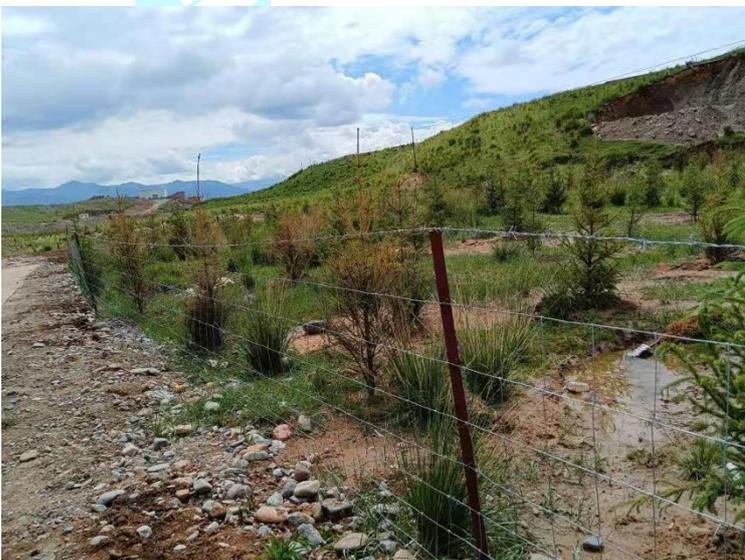
围栏标准要求采用青 Q/JB76-88《缠绕式镀锌钢丝围栏》，采用加密围栏，围栏规格为 91L-8/110/15（即纬线 8 根，纬宽 1.1m，经线间距 15cm），钢丝伸长率不小于 4%，反复弯曲次数规格：顶 10×10cm，底 15×15cm。相邻纬线自上而下间距为 20cm、18cm、18cm、15cm、13cm、13cm、13cm。
