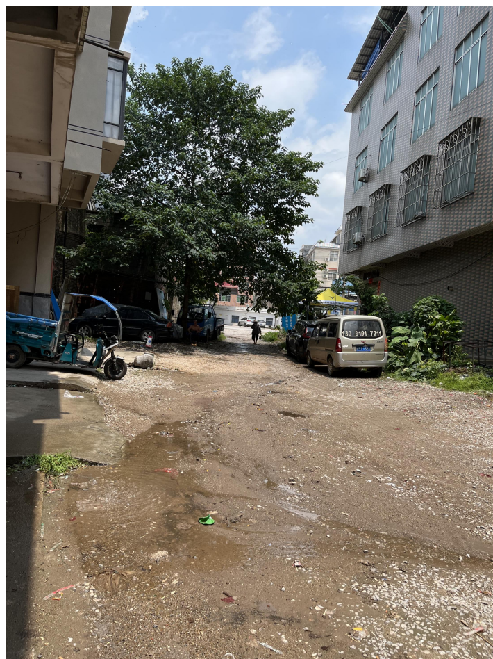
B 道路水泥路面终点
