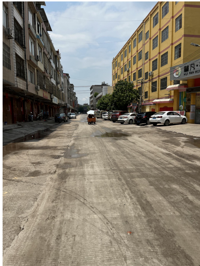
教育路加铺沥青路面终点
