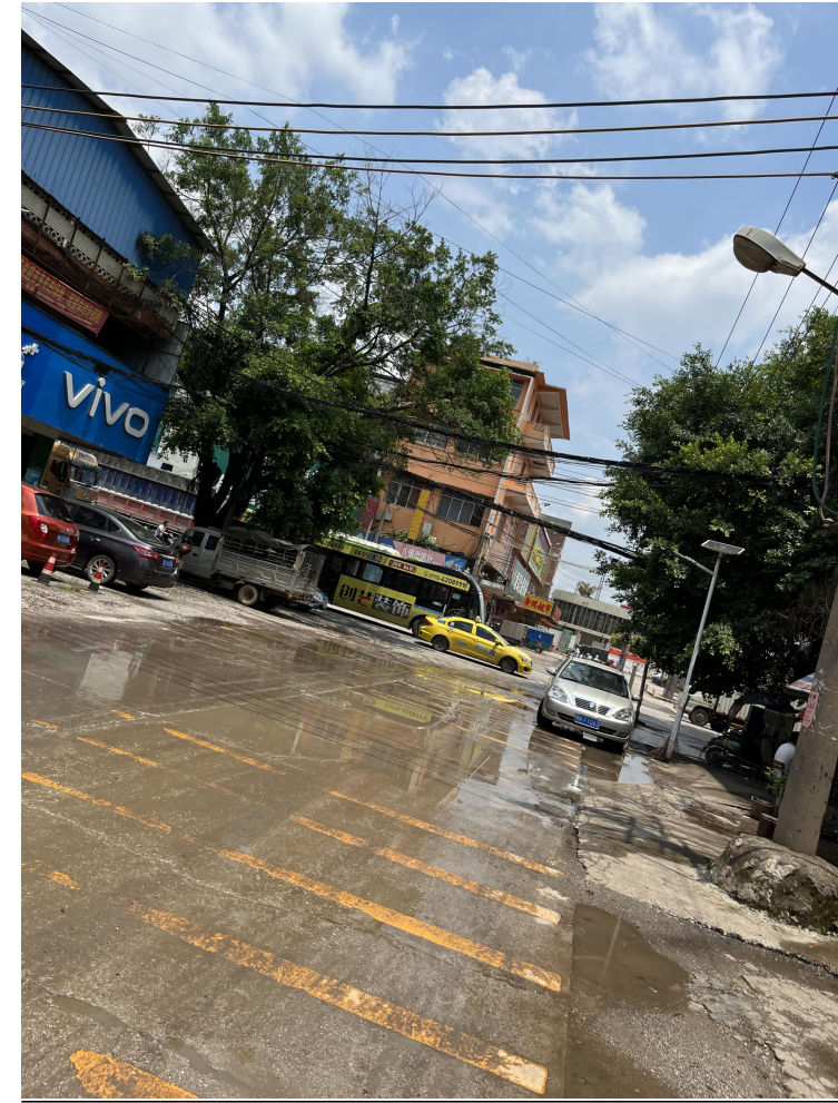
A 道路加铺沥青路面终点
