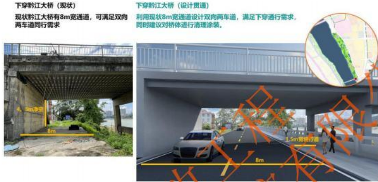
图 6-16 下穿黔江大桥段交通关系图
