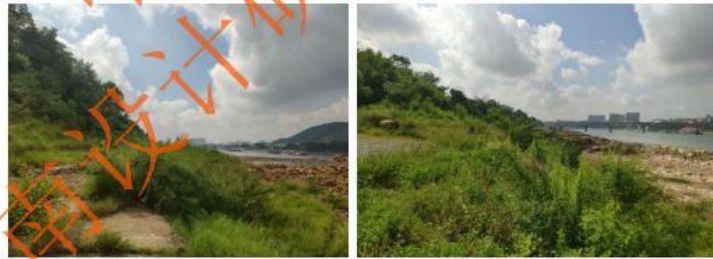
图 3-1 黔江左岸河道现状 (1)
