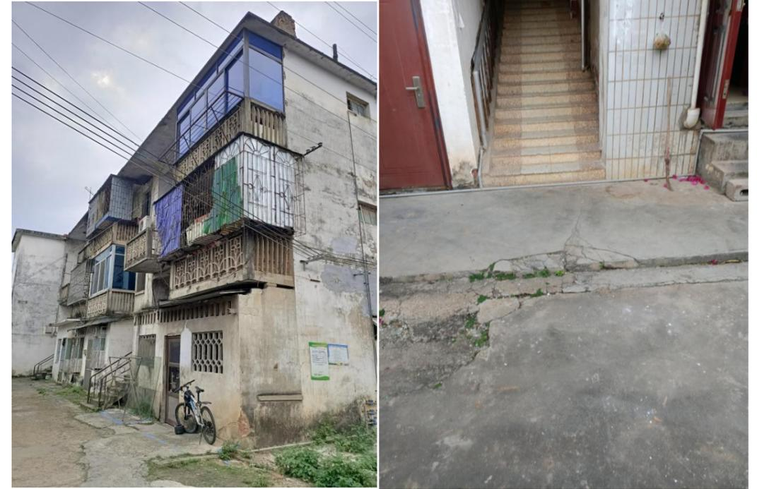
图 3.1.18 部分小区路面破损图
