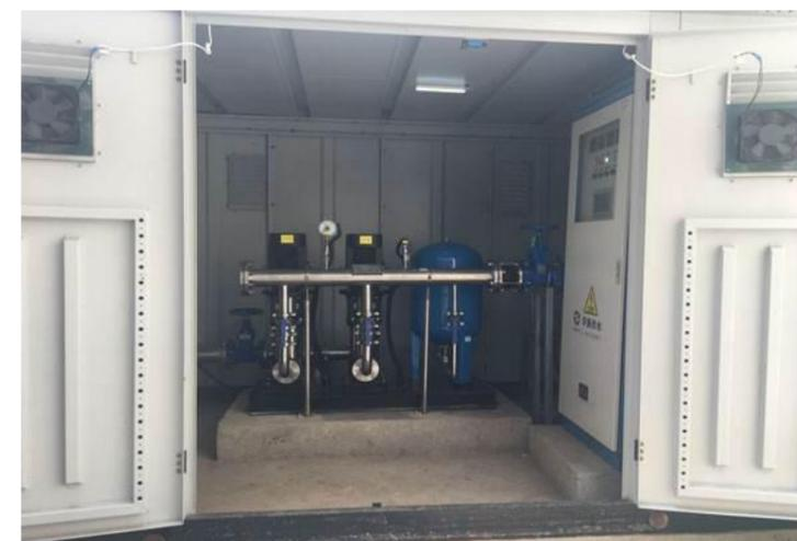
图 5.2.23 供水加压泵示意图
