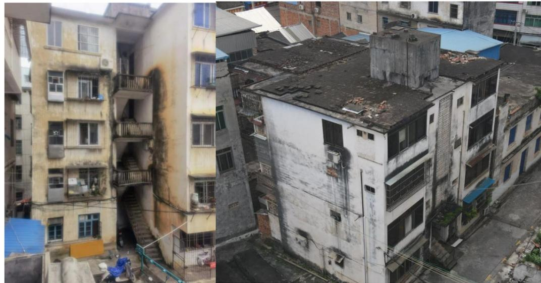
图 3.1.21 房屋顶漏水严重图
