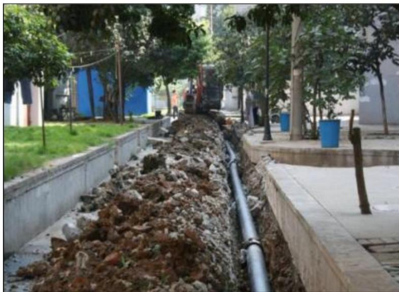
图 5.2.8 更新、维修供水管
