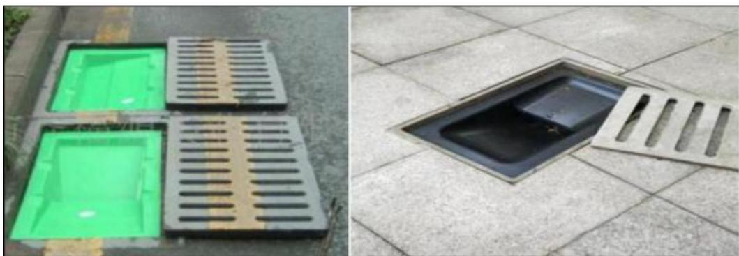
图 5.2.24 雨水沟设防蚊闸示意图
