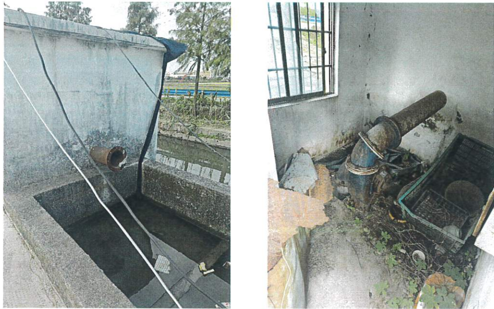
直落红河下横沟泵站现状
