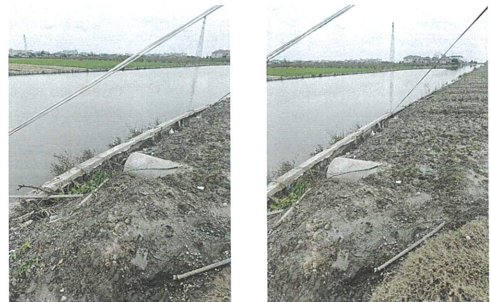
新塘台湾地泵站现状
