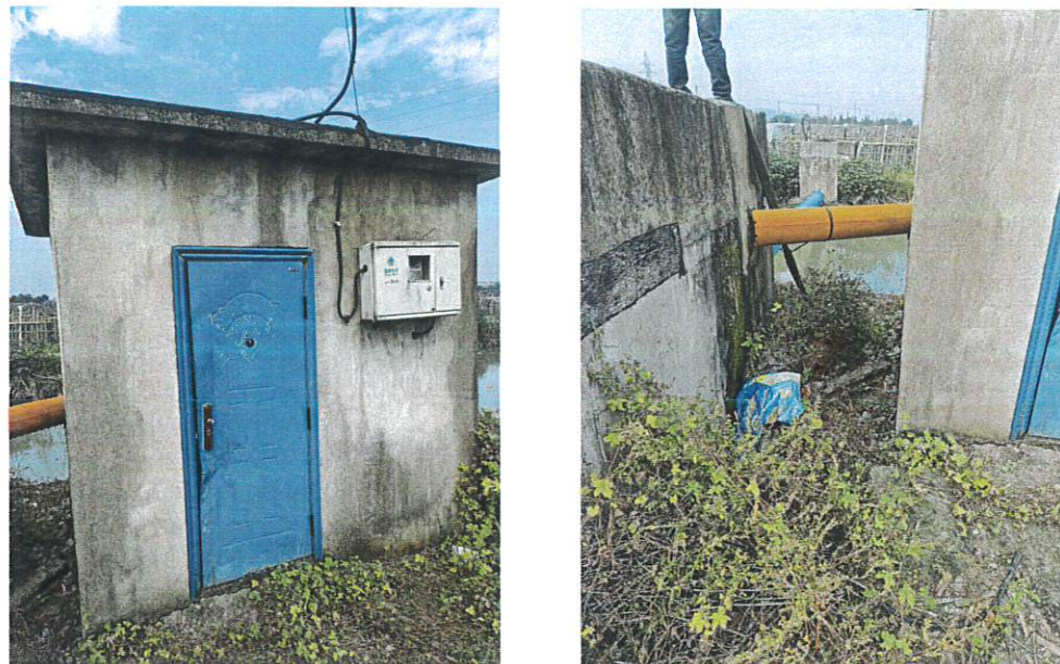
庙山泵站现状
