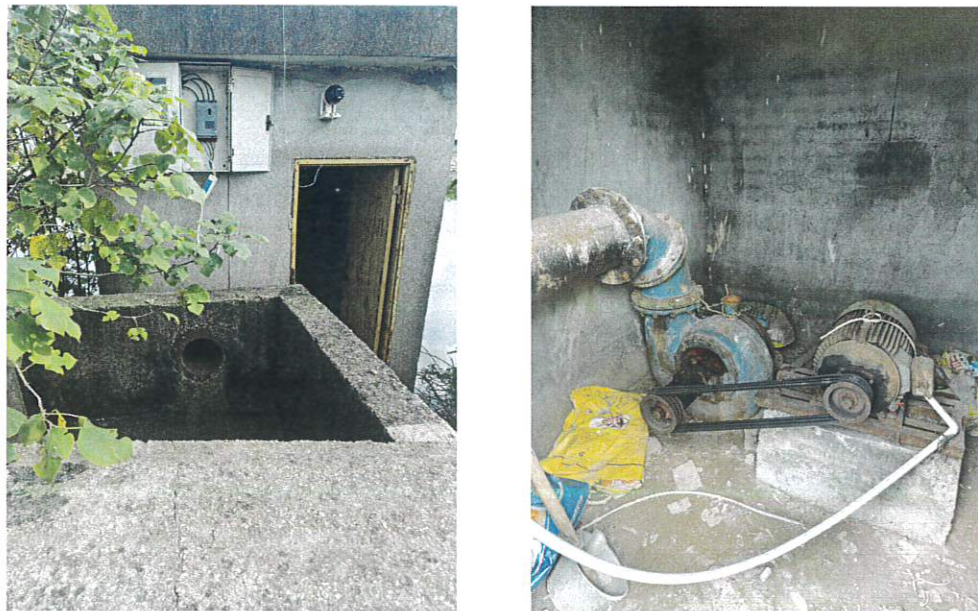
牛眼槽水泵泵站现状
