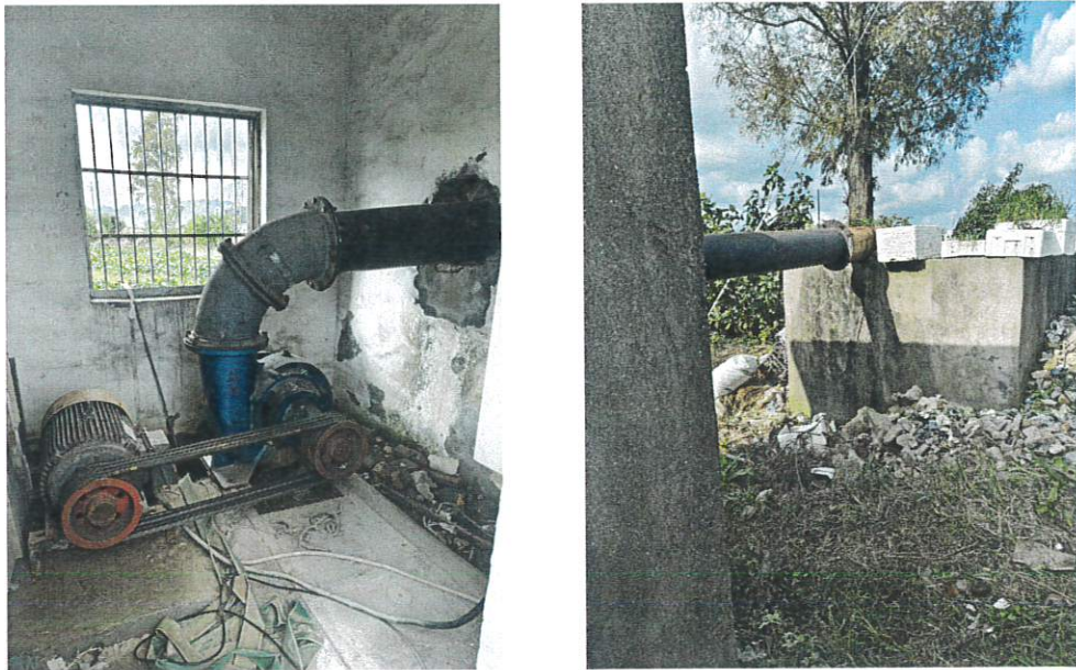
下洪前水泵泵站现状
