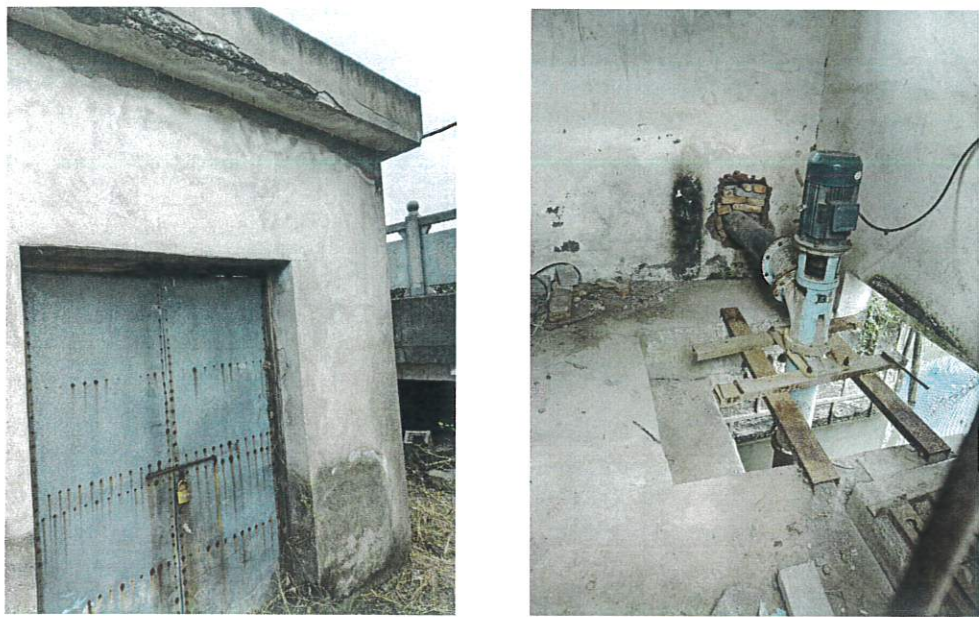
30 米大道北边泵站现状
