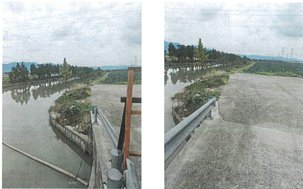
五塘横江南泵站现状
