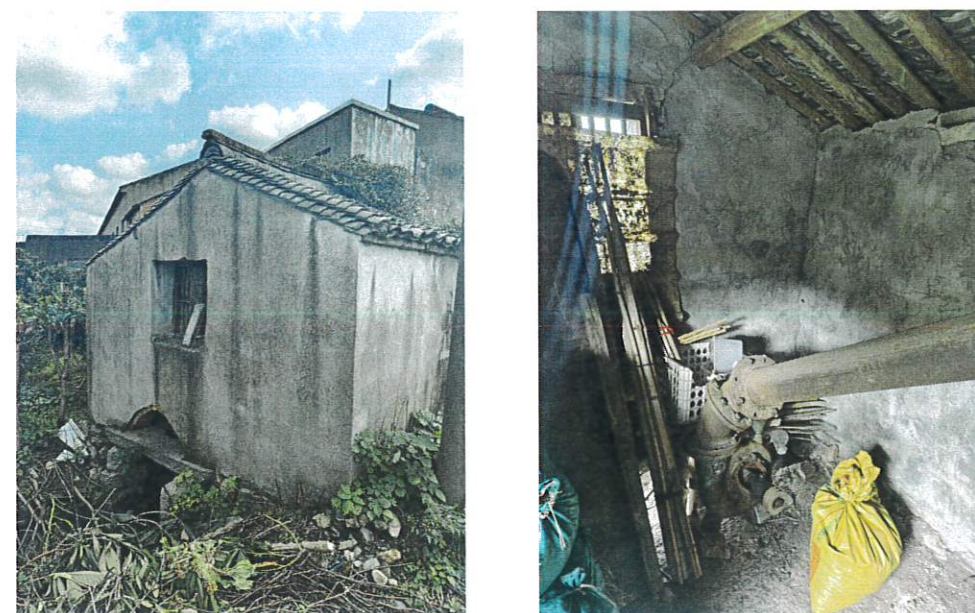
潘岙江引水泵站现状
