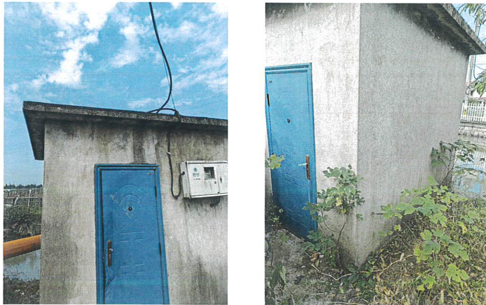
门前沿河泵站现状
